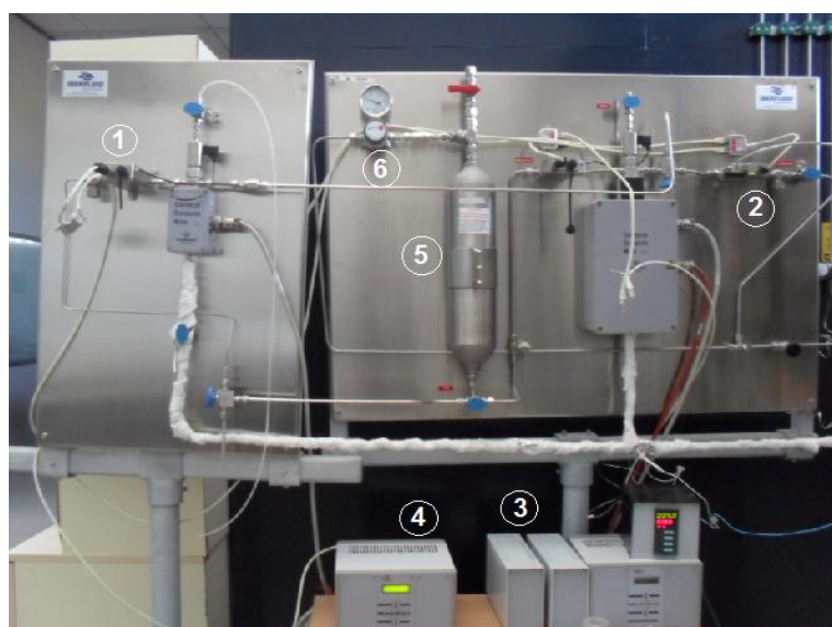
Figura B.7- Fotografía del sistema de generación de vapor de la instalación de fase gas a presión.
