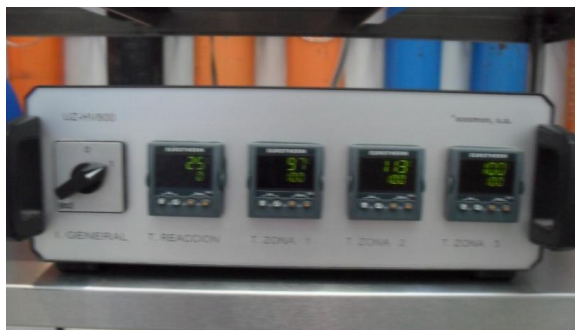
Figura B.28- Fotografía del sistema de control de temperatura del horno de la instalación de fase gas a presión.
