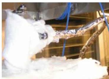
Figura B.5- Recubrimiento de la cabeza del reactor con lana de cuarzo en la instalación de formación de hollín.
