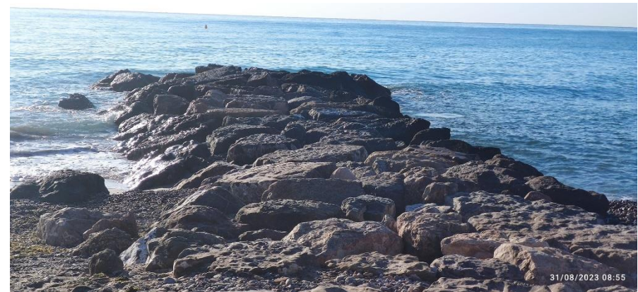
Ilustración 14. Espigón 2 (pendiente demolición) 2
