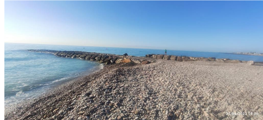
Ilustración 16. Espigón 3 (pendiente rehabilitación) 1
