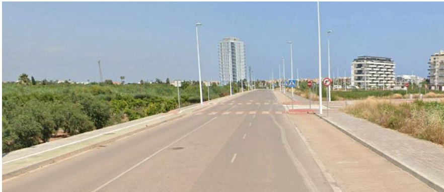
Ilustración 4. Calles de acceso a la obra.
