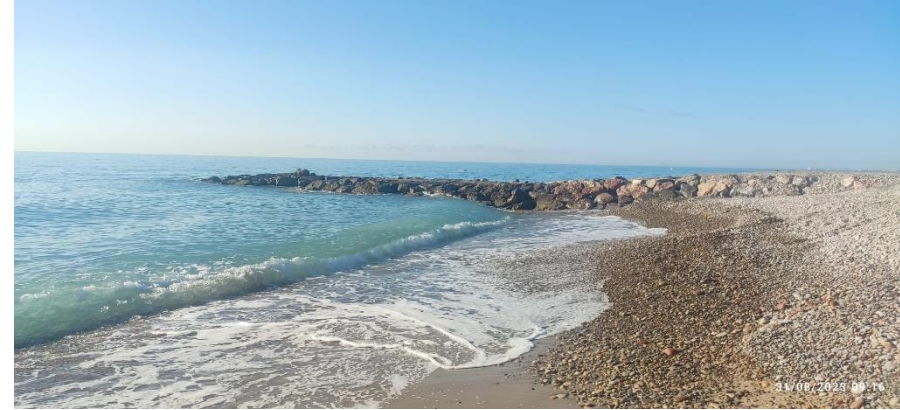
Ilustración 22. Espigón 4 (pendiente demolición) 1
