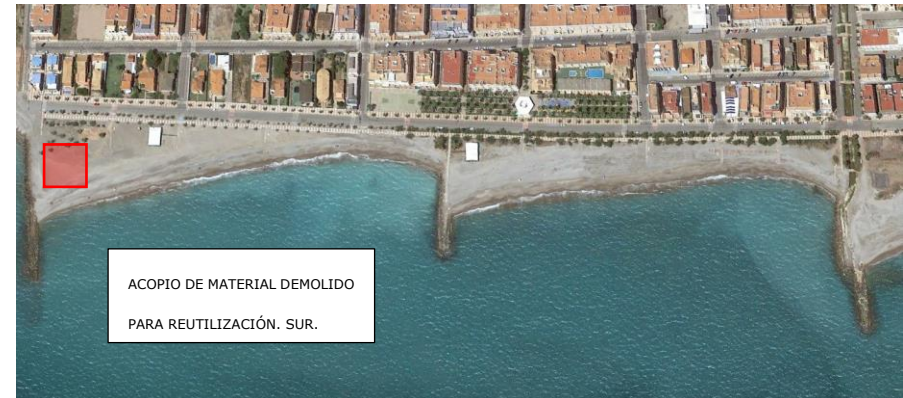
Ilustración 7. Ubicación acopio temporal Todo Uno en Zona Sur.
