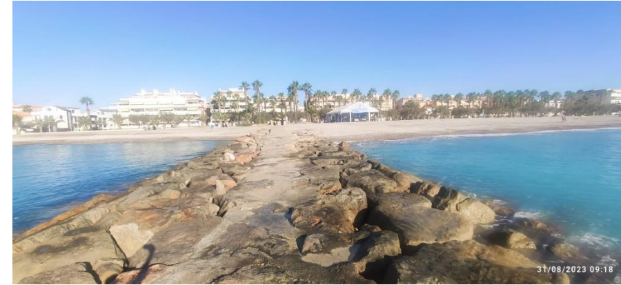
Ilustración 25. Espigón 4 (pendiente demolición) 2
