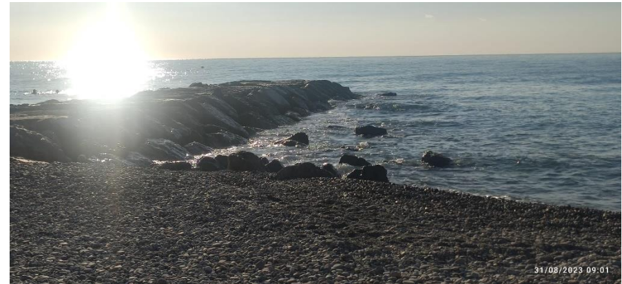
Ilustración 12. Espigón 2 (pendiente demolición) 1
