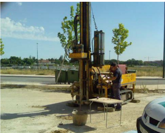
Emplazamiento del sondeo 1
