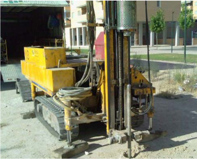
Emplazamiento del sondeo 3
