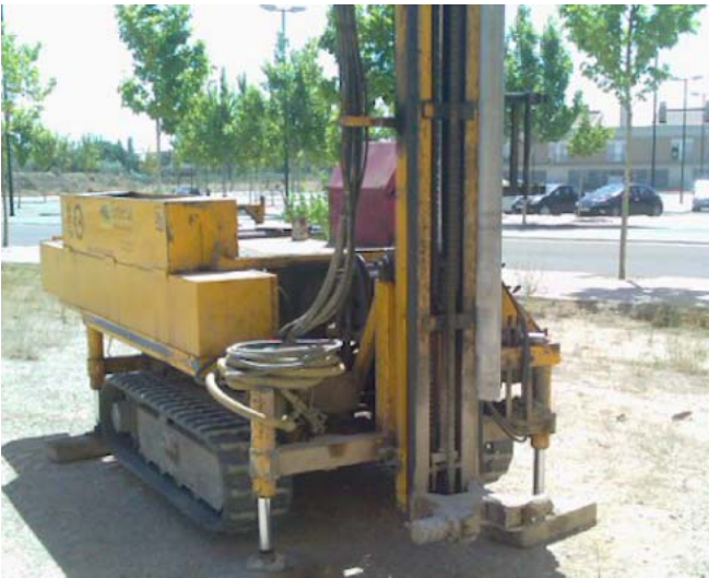
Emplazamiento del sondeo 2
