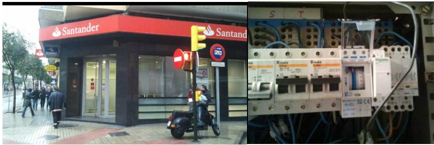
Figura 12. Interruptor horario para el encendido y apagado del rótulo exterior y banderola.
