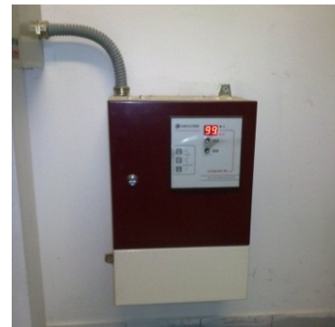
Figura 22. Batería de condensadores compensación de Energía Reactiva.
