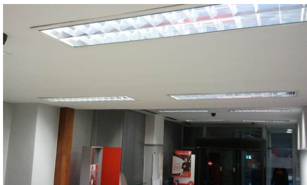
Figura 17. Tipo de iluminación fluorescente tubular.
