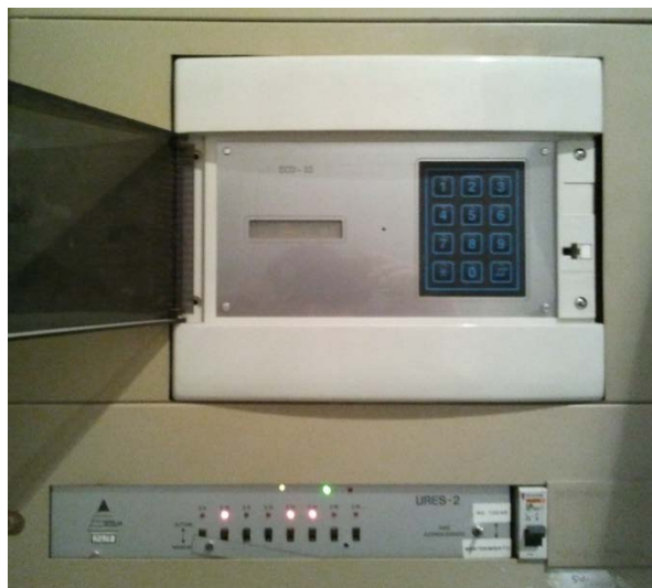
Figura 26. Control automático centralizado de la desconexión de la iluminación.
