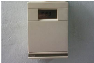
Figura 15. Termostato de control de la máquina principal de climatización.
