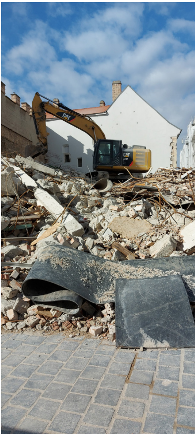
Fig. 3.22. La demolición de la Casa Diplomática tuvo lugar en 2021.
