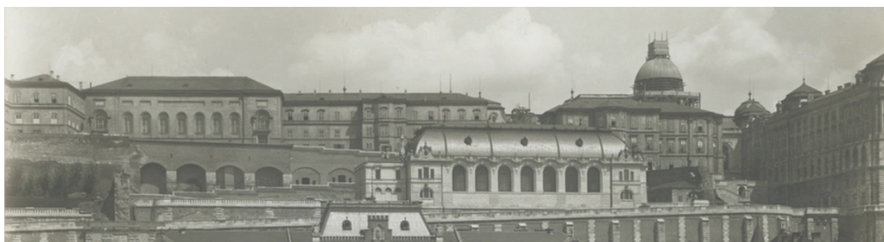
Fig. 3.8. La Sala de Equitación recién entregada. Se observa también el sistema de rampas todavía en construcción.
