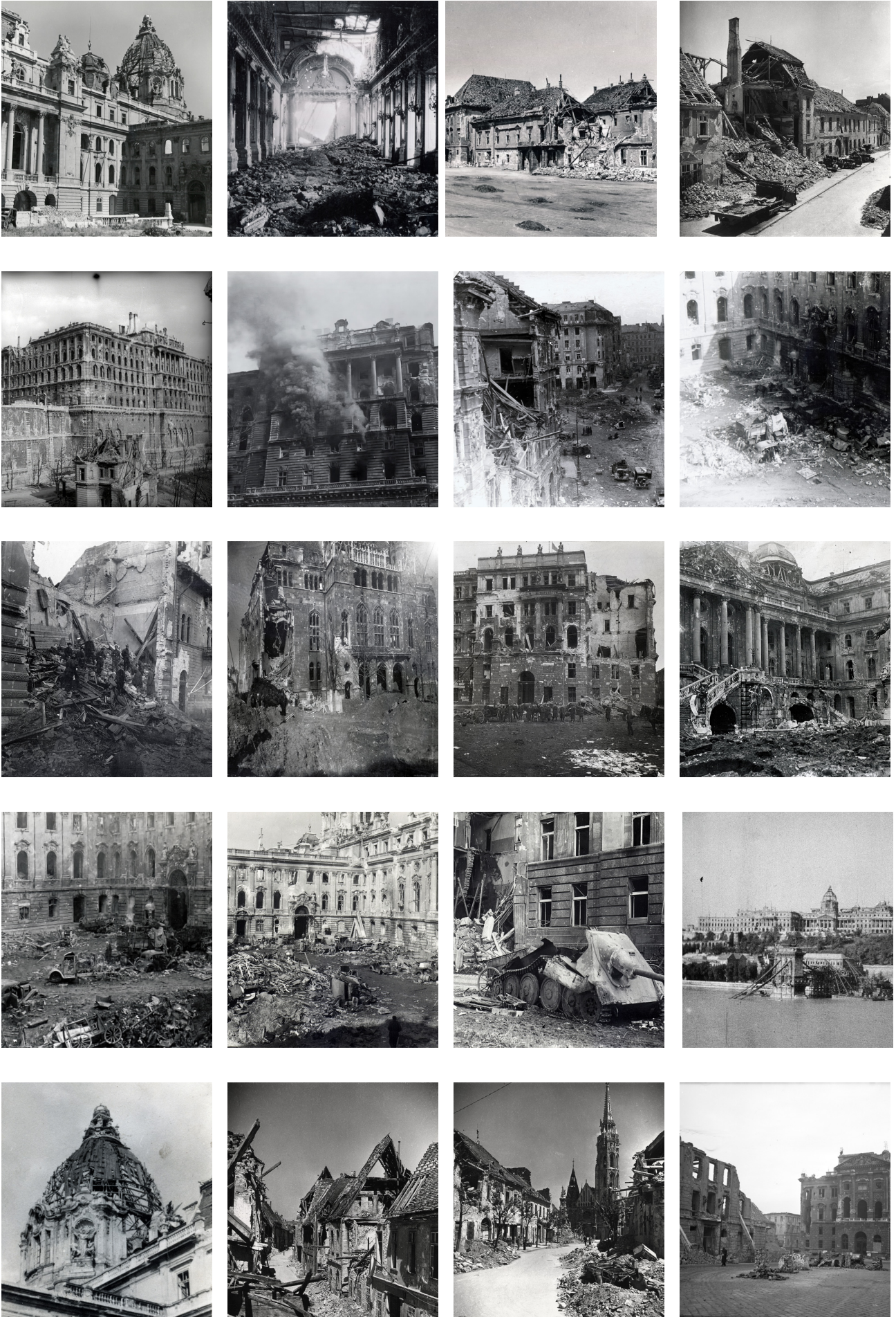
Fig 2.8. Fotografías tomadas en el Barrio del Castillo tras el asedio de 1945.
