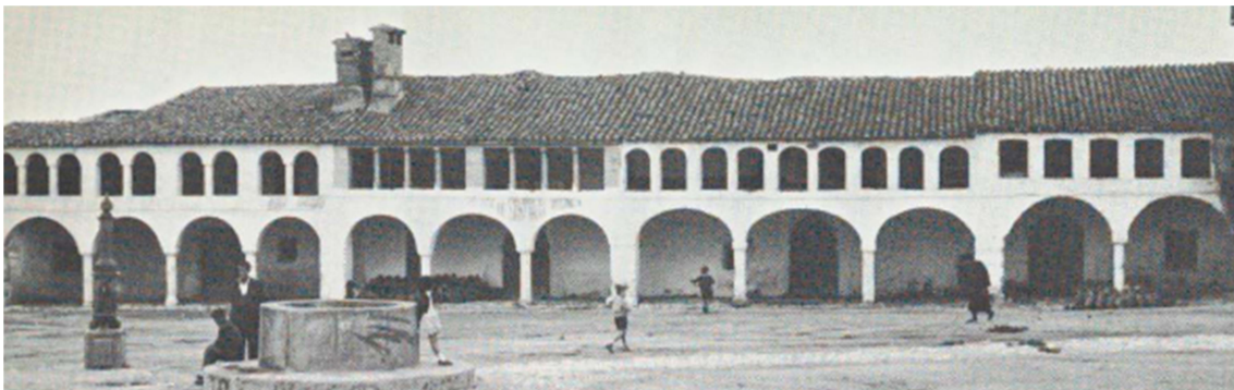
Imágenes de la publicación Arquitectura sin arquitectos . Arriba Arquerías de Benabarre (Huesca), Garrovillas (Cáceres) y Caldes de Reyes (Pontevedra) Abajo. Conjunto de la plaza de Garrovillas (Cáceres)
