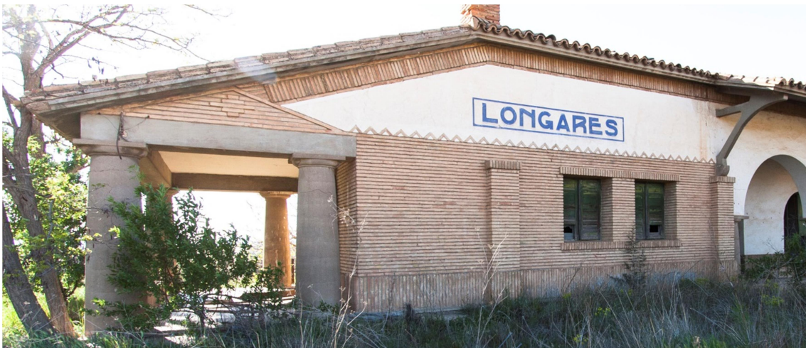
Edificio de viajeros de Longares. Tratamiento del ladrillo.
