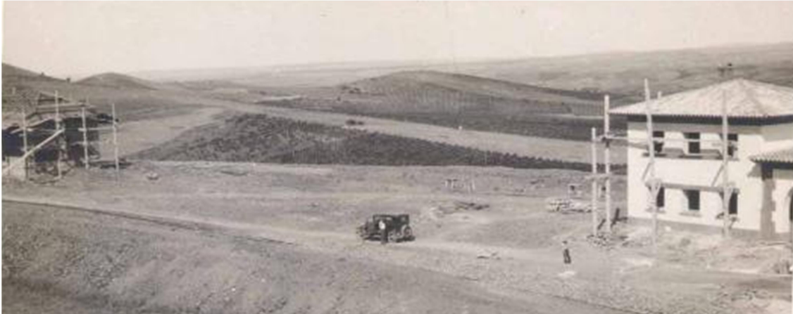
Construcción del edificio de viajeros de Encinacorba y Muelle cubierto. Fotografía ATAF Cariñena.
