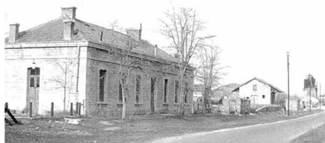
Dcha. Edificios de viajeros de las estaciones de Calamocha-Vega (arriba) y Caminreal (abajo) pertenecientes a esa línea.
