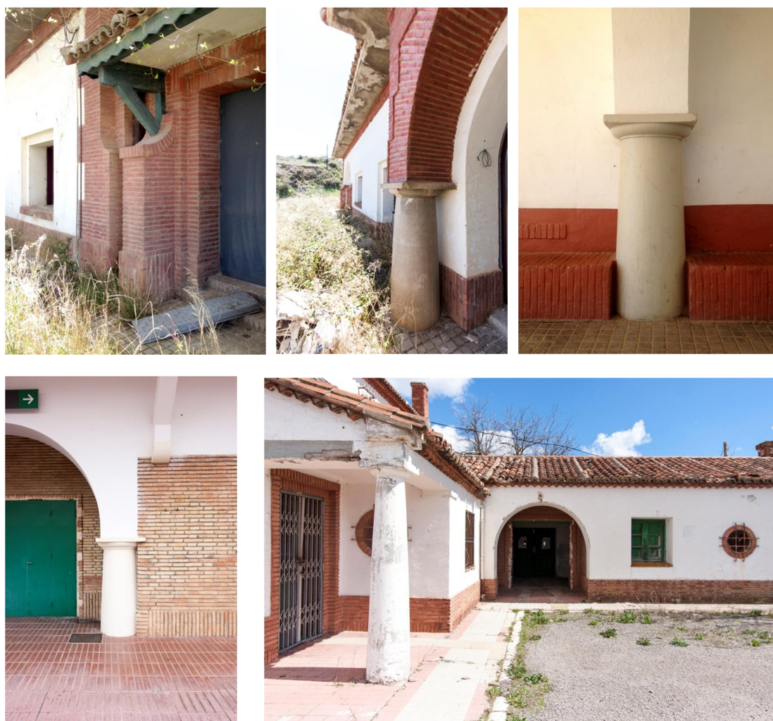
Detalles de los edificios de viajeros (estado actual) que reflejan el rigor y la sobriedad constructiva. Arriba Encinacorba (izda y centro) y Cariñena (dcha) . Abajo María de Huerva (izda) y Caminreal (dcha)
