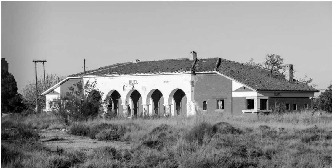
Arriba. Imagen de uno de los Edificios Tipo de viajeros (sin definir) de Secundino Zuazo para la línea Caminreal-Zaragoza publicada por la revista Arquitectura Española Contemporánea (1928). Abajo. Estación de Muel. (2017)
