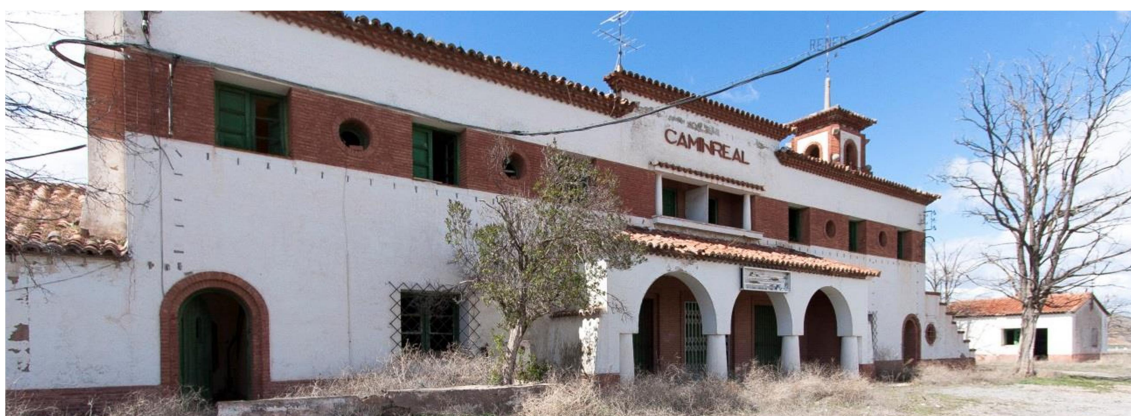
Estación de Caminreal. Fachada hacia el pueblo. Fotografía del estado actual
