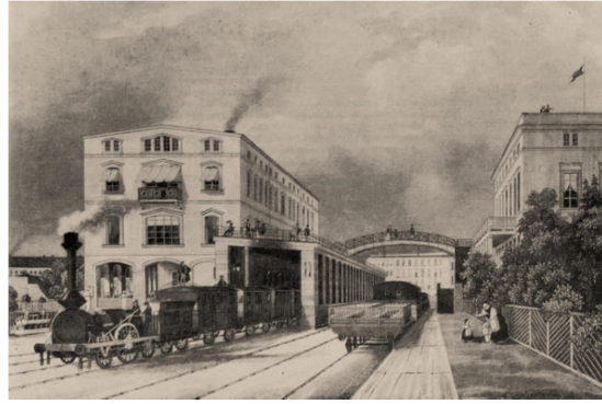
Estación de Potsdam (Berlín), 1838. Estación de término con servicio en un único lado y por lo tanto con un único andén para embarco y desembarco. Aunque haya cierta dificultad con el tráfico de viajeros se considera que el movimiento de trenes era más ventajoso.
