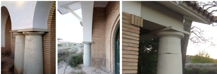
Detalles de la materialidad de los pilares de Botorrita
