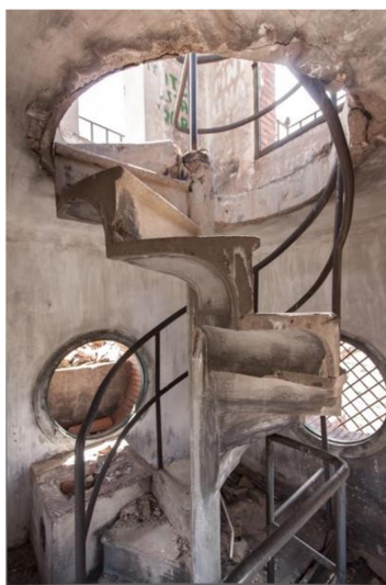
Gutiérrez Soto. Edificio de viajeros de Caminreal. Torre vigía.
