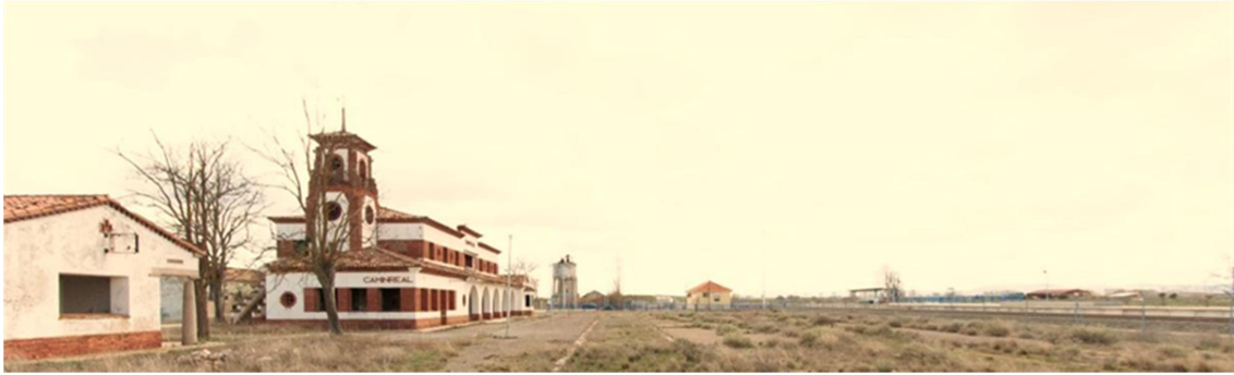
Estación de Caminreal. Vista desde la llegada en tren desde Zaragoza.
