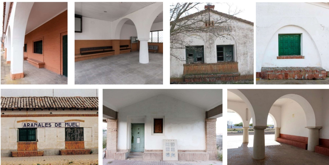
Bancos integrados como parte del mobiliario. Edificio de viajeros de Calamocho, Cuencabuena, Badules, Arañales, Botorrita y Cariñena,
