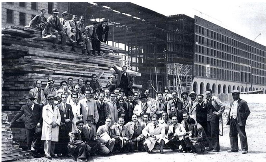
Visita de un grupo de arquitectos (Zuazo en el centro) a las obras de Nuevos Ministerios en 1935. Zuazo siempre ejerció de maestro para quien quiso aprender de él.
