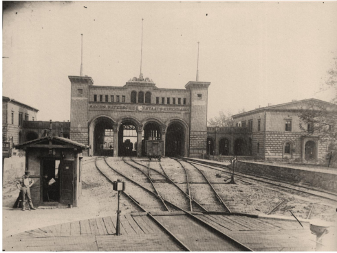
Estación de Leipzig. 1842. Compañía ferroviaria Sajonia-Bávara. Arq. Eduard Pöetzsch (1803-1889). Pabellón o hall abierto por los dos lados, estructura en U, rota por la necesidad de prolongar las vías en la fachada principal.. Tipo de estación con los servicios en los laterales.
