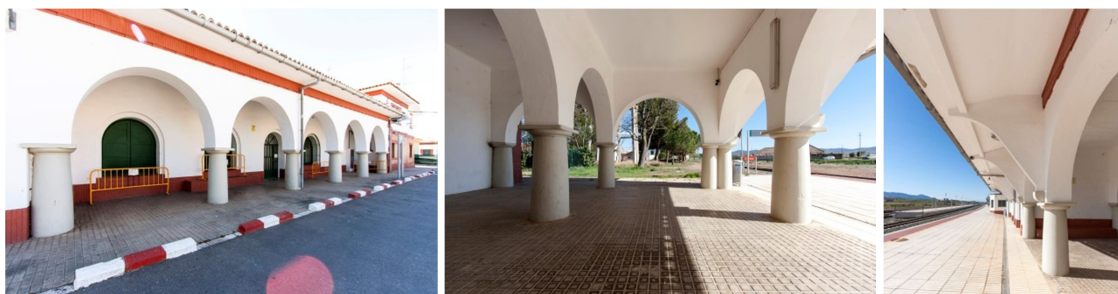
Secundino Zuazo. Estación de Cariñena. Fotografías del estado actual.
