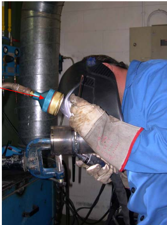
Fotografía VIII.2: Ensayo de soldadura manual
