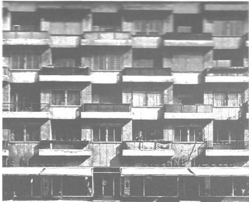
Fritz Sillings og Magner Stephensen: Gammel Kongevejgården, Gammel Kongevej 72-76, 1929. Jernbeton. Forsatte altaner.
