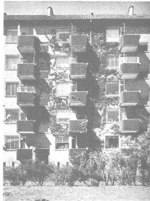
Knud Hansen: Foreningen Socialt Boligbyggeri. Boligbebyggelse på Tomsogaardsvej 83-103 i København, 1941. Type med frihængende altaner uden afskærmning.
