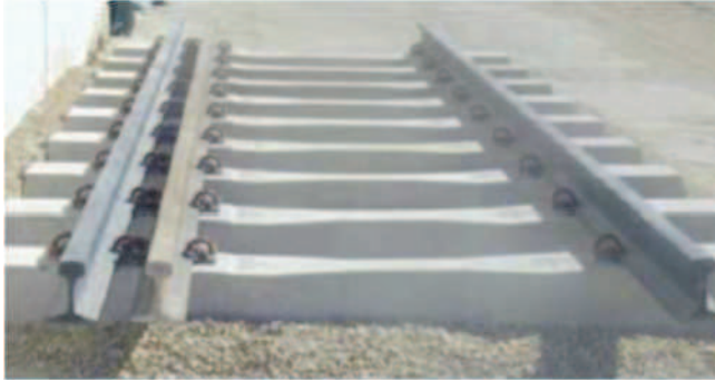
Imagen 16.7 Tramo de vía de ancho mixto, imagen (Fuente la vía de tres carriles, ver bibliografía)
