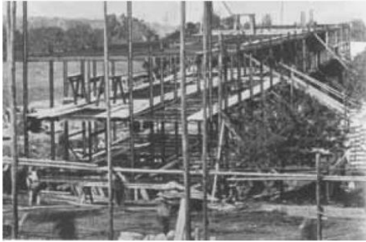
[21] Armazón de acero de las viviendas de Mies
