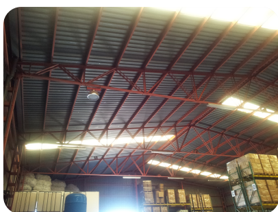
Figura 11.- Lucernarios, fluorescentes y pantalla de vapor de mercurio
