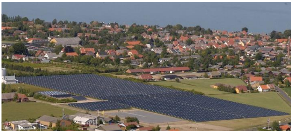
Figura 1. Planta solar térmica de distrito con acumulación estacional en Marstal, Dinamarca [8].
