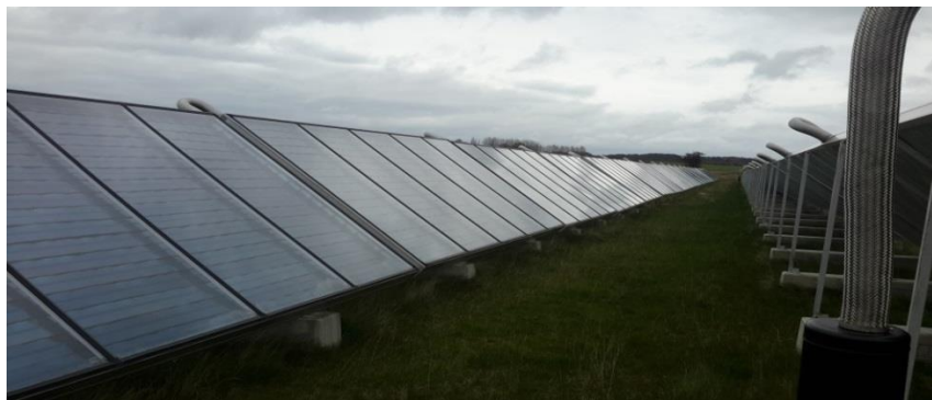
Figura 3. Captadores planos de gran tamaño de una planta solar térmica de distrito (Jaegerspris, Dinamarca).
