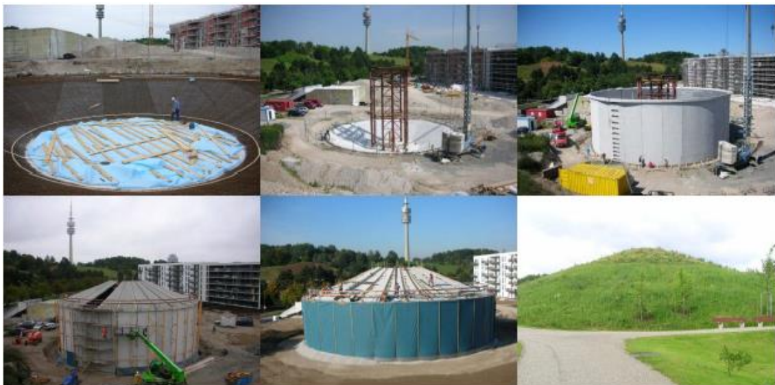
Figura A11. Diferentes fases de construcción del acumulador estacional construido en Munich, Alemania.
