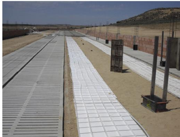
Foto 1. Instalación de suelo radiante en una explotación de porcino
