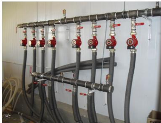
Foto 6. Detalle de las tuberías generales de ida y retorno en una instalación de varias naves
