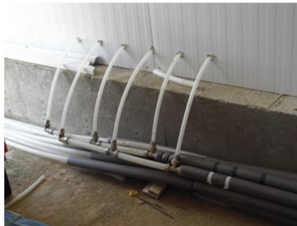
Foto 4. Detalle de los colectores.
