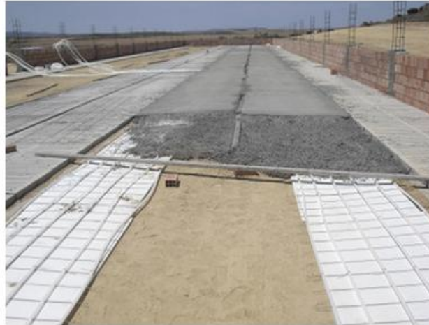
Foto 3. Hormigonado de la solera
