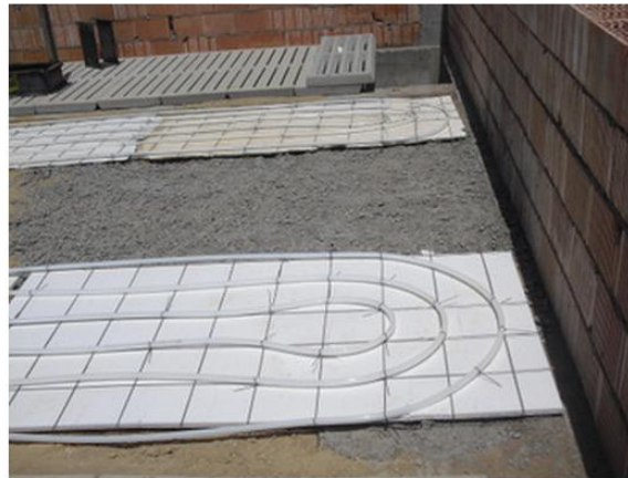
Foto 2. Detalle de la instalación donde se aprecian las tres tuberías, Las placas aislantes y el mallazo de sujeción
