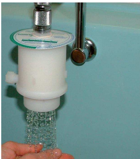
Figura 57. Sistema de purificación en punto terminal mediante filtro desechable con caducidad limitada desde su inicio de uso.
