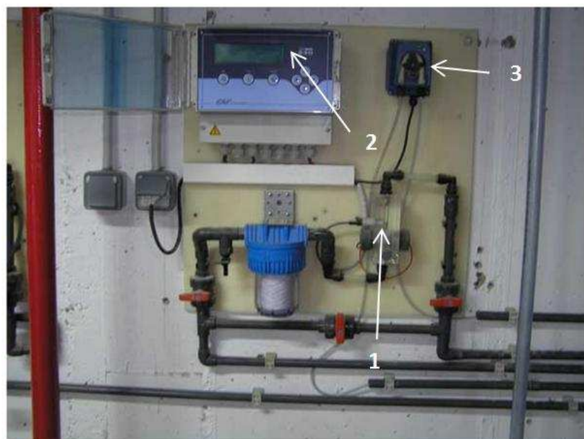
Figura 41. Sistema de cloración en continuo
