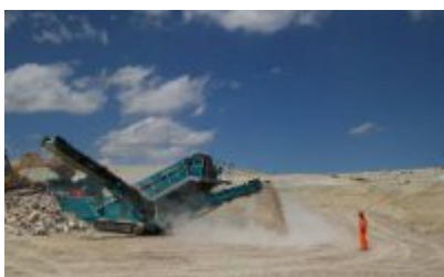
Figura 22: Área de tratamiento de residuos de obras menores
