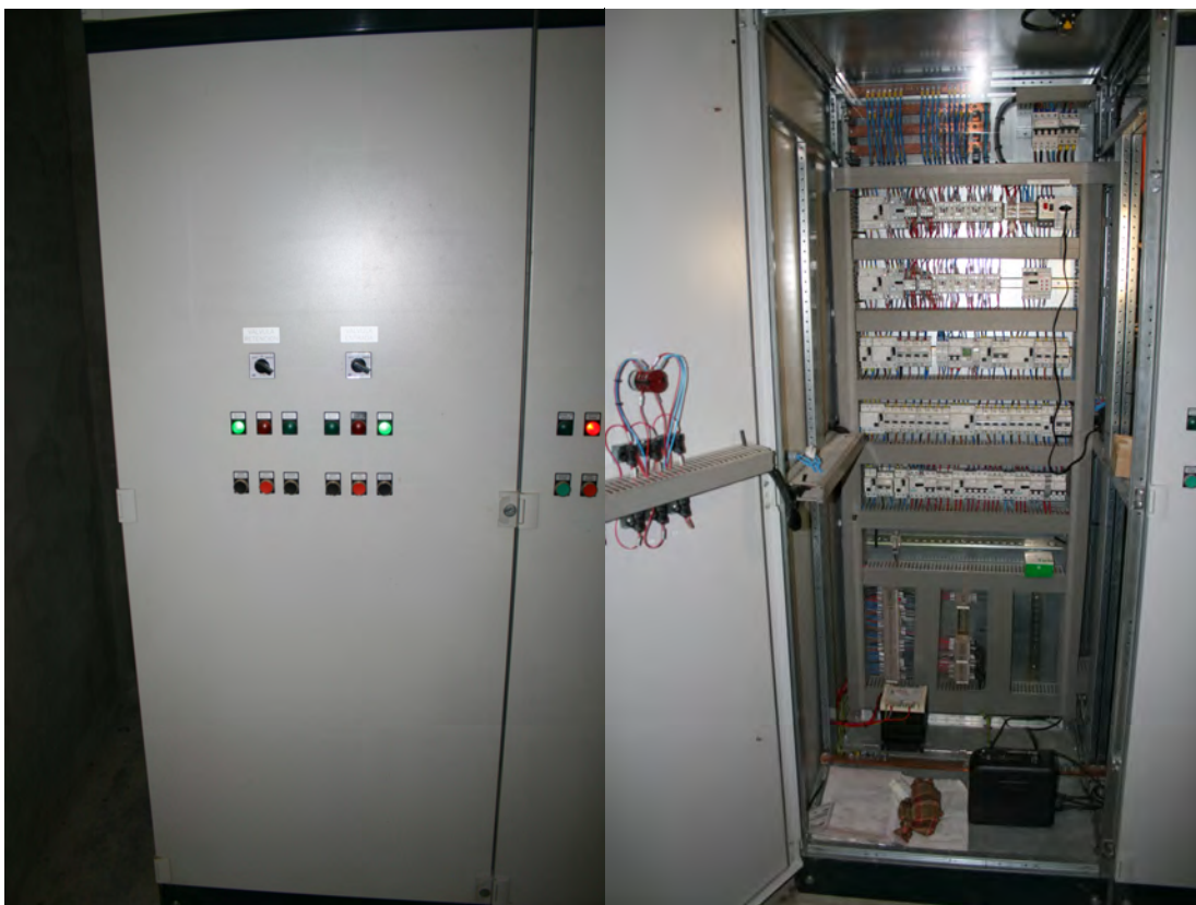
Fig. 8.40 Imagen de módulo de armario de gestión de servicios generales y válvulas de entrada
