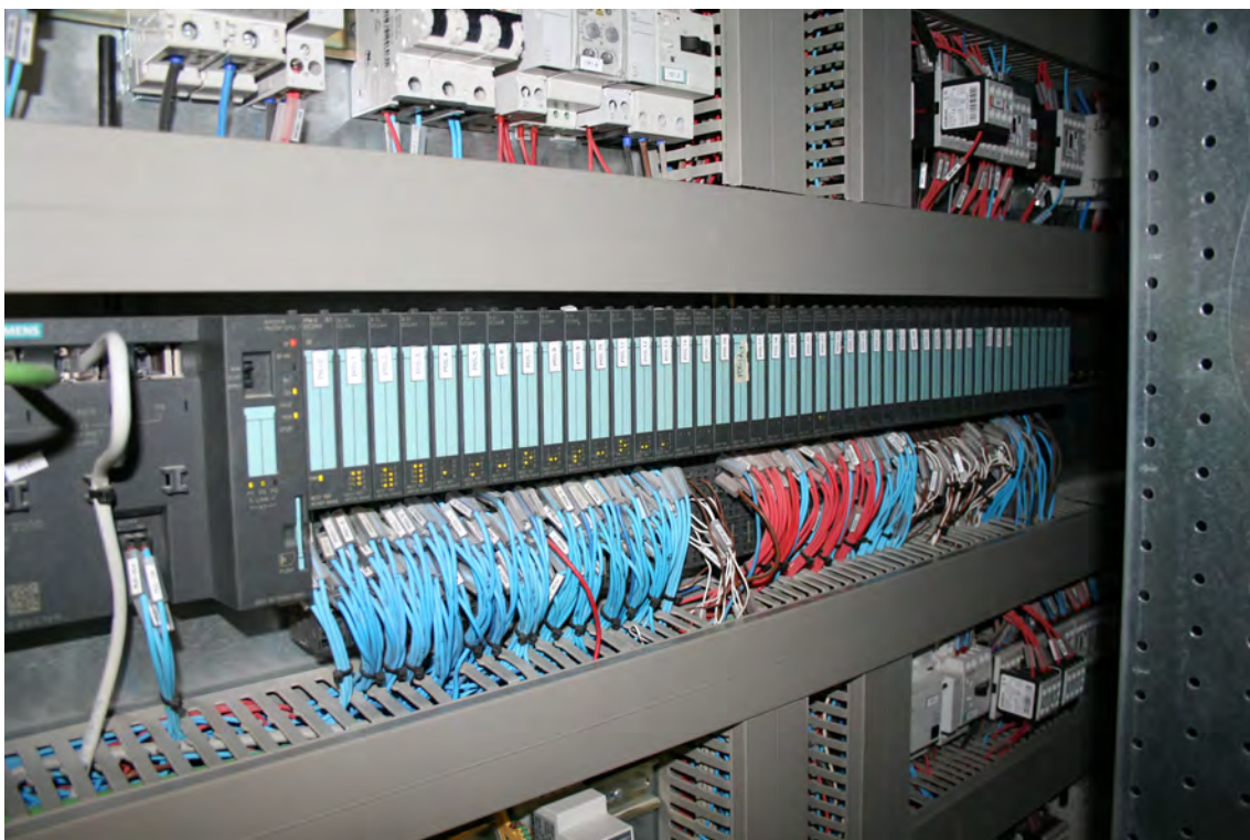
Fig. 8.42 Imagen de detalle de PLC de control instalado
