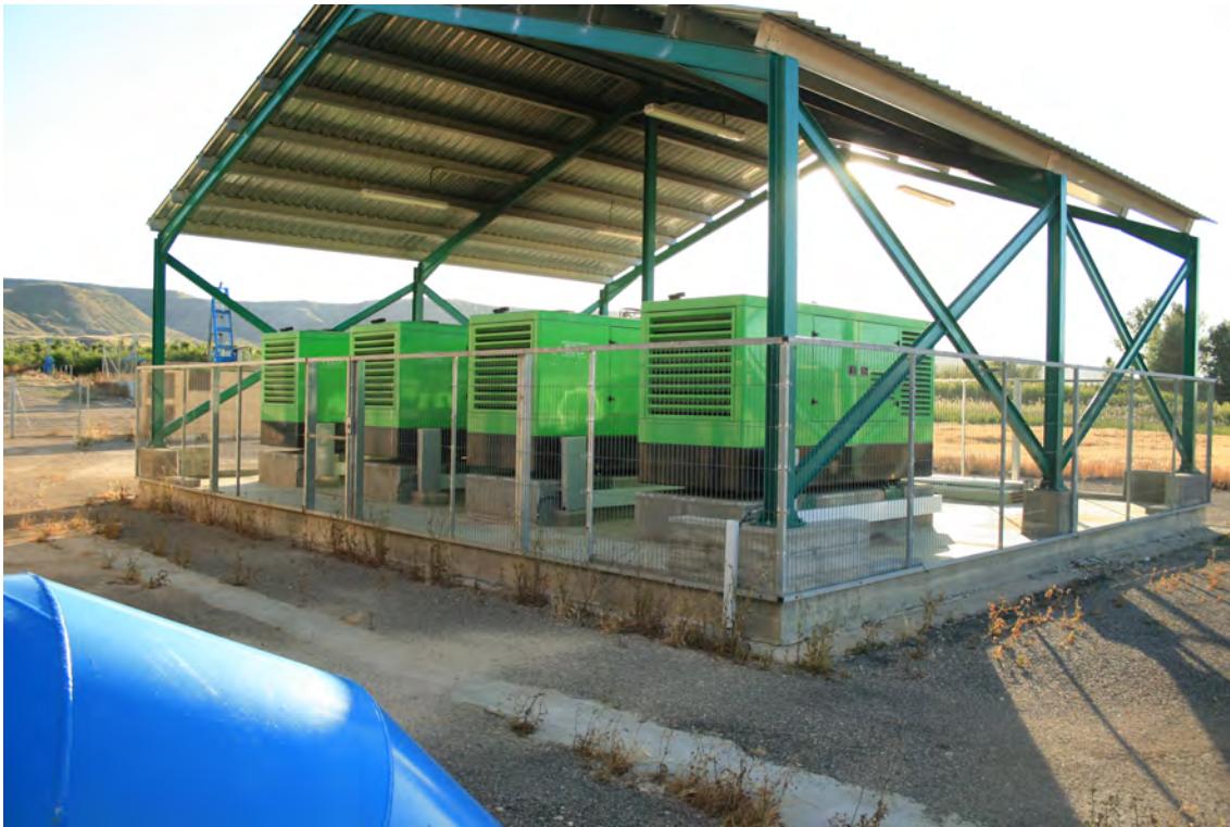
Fig. 8.25 Imagen de ubicación de grupos electrógenos de instalación. Solo el 3 en servicio.
