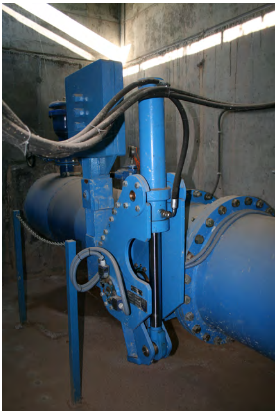
Fig. 8.6 Imagen de válvula de sobrevelocidad de CMO
