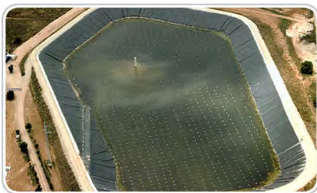
Fig.2.6 Balsa de regulación con lámina PEAD
