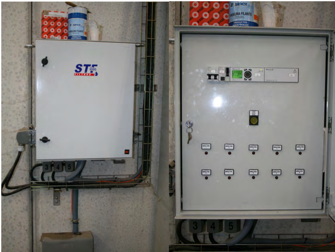
Fig. 8.31 Imagen de armario de control de limpieza de filtros STF FMA2000.
