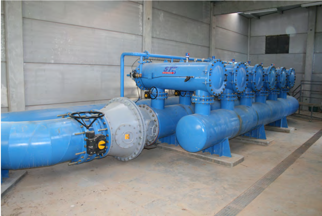
Fig. 8.14 Imagen de unidades de filtrado intermedio STF FMA2000
