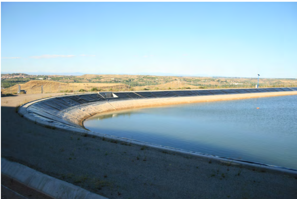
Fig. 8.2 Imagen de balsa de regulación con arqueta de aliviadero
