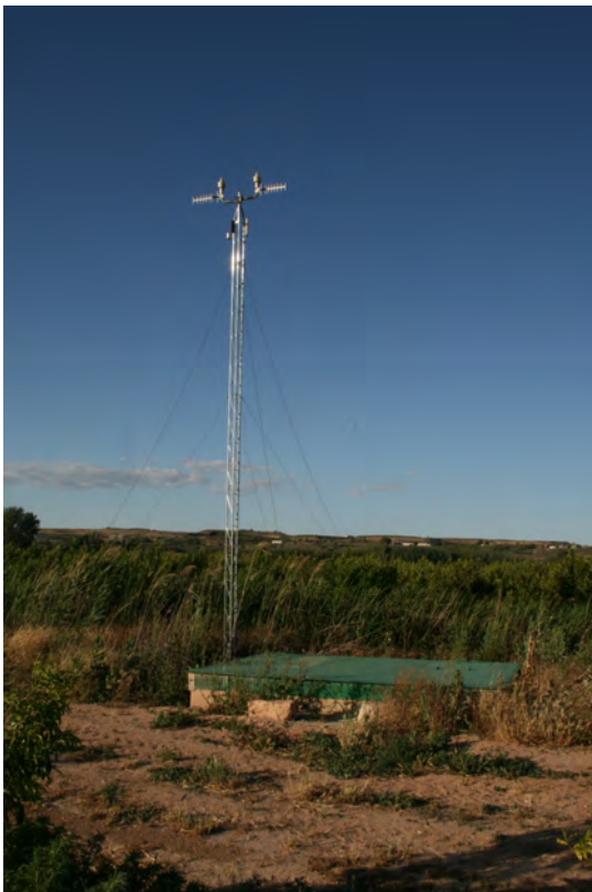
Fig. 8.15 Imagen de arqueta de control T3-T4 señales WIFI y 869 para telecontrol
