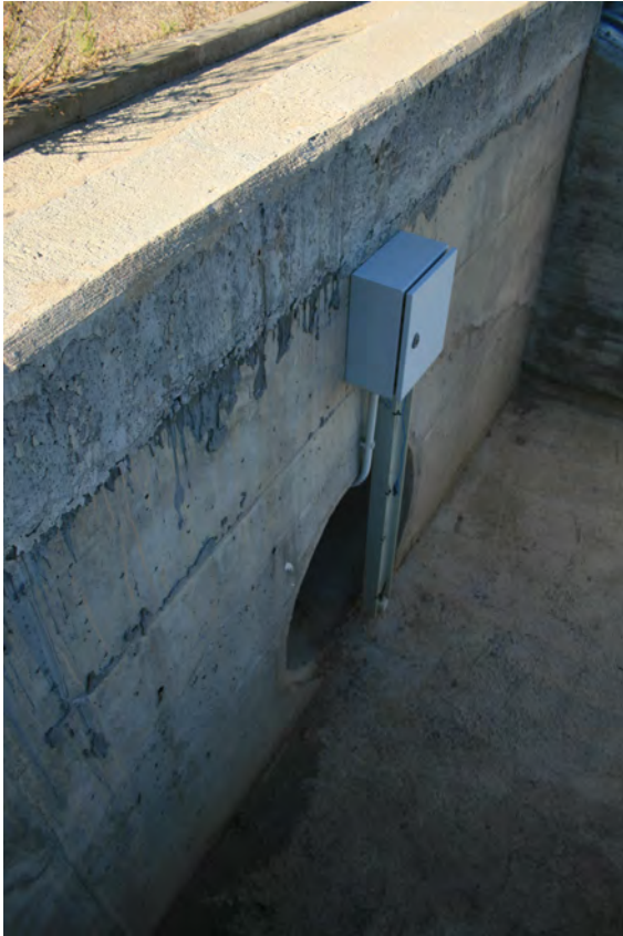
Fig. 8.3 Imagen de arqueta de aliviadero con detección de fuga por electrodos
