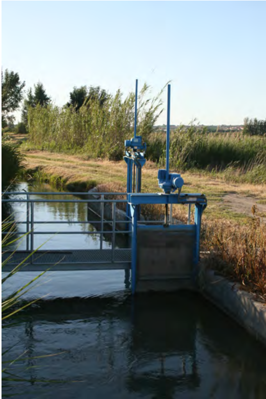
Fig. 8.20 Imagen de válvulas de entrada y retención de canal
