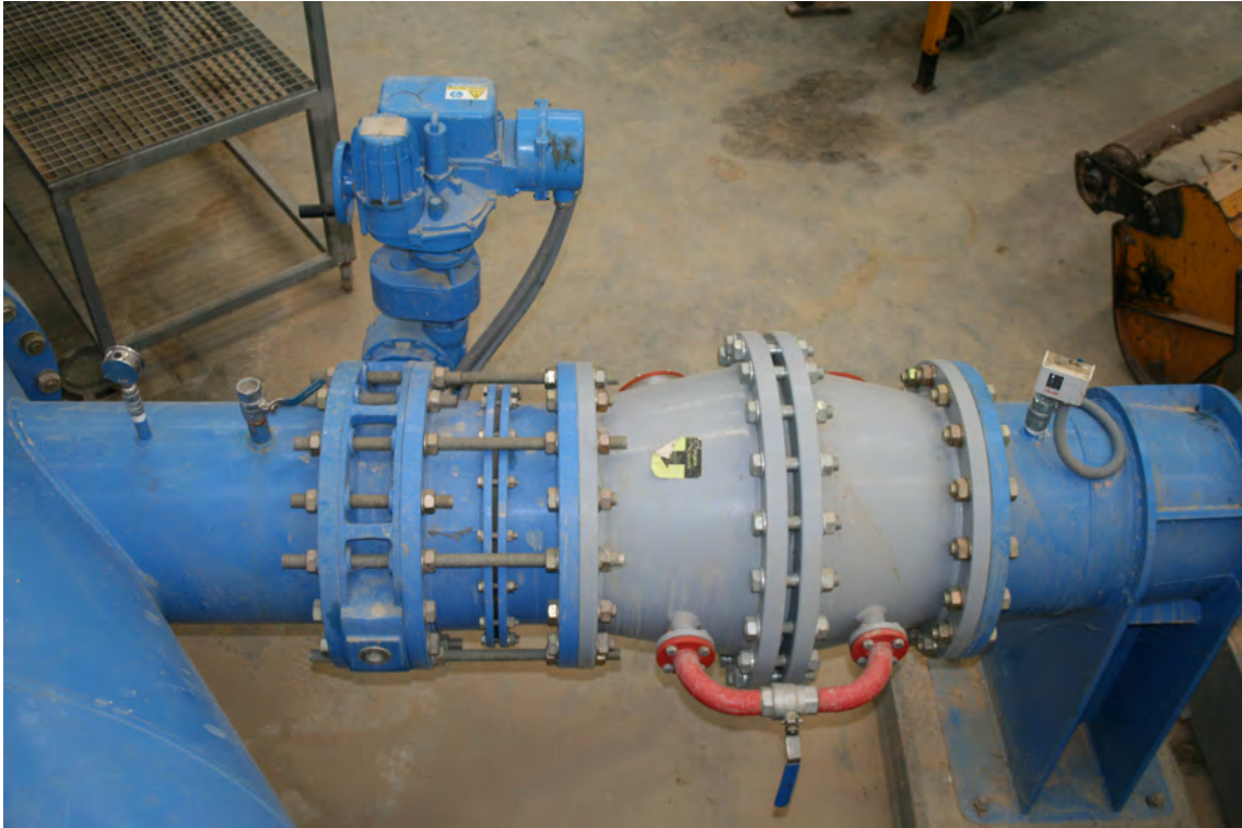
Fig. 8.33 Imagen de válvula motorizada de salida de bombas.
