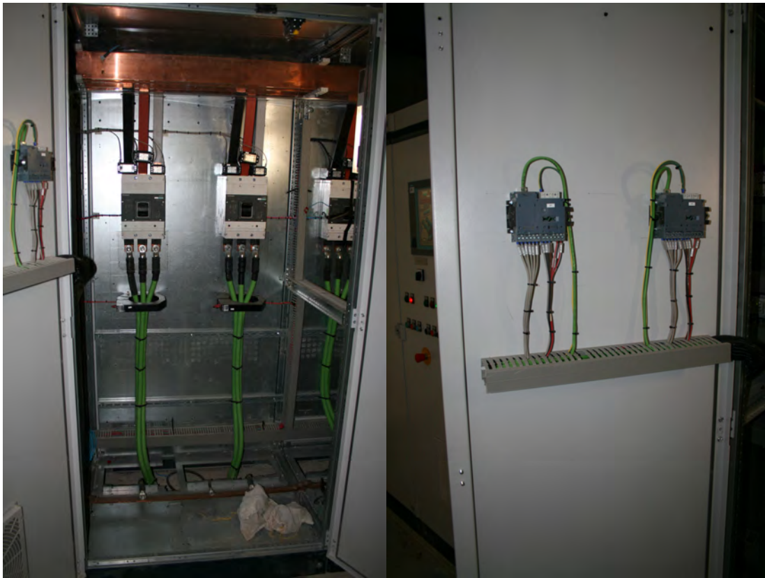
Fig. 8.44 Imagen de módulo de control de potencia de bombas y analizadores de redes individuales por bombas
