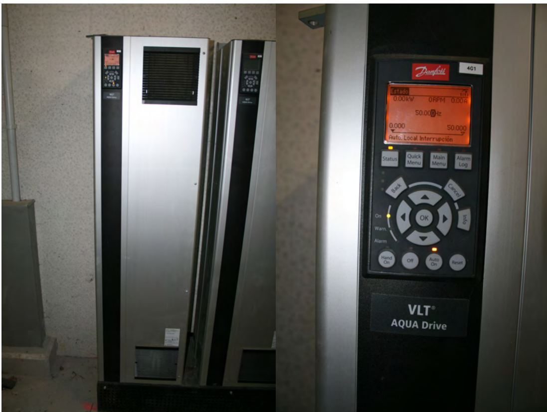
Fig. 8.38 Imagen de unidad de variador instalada.
