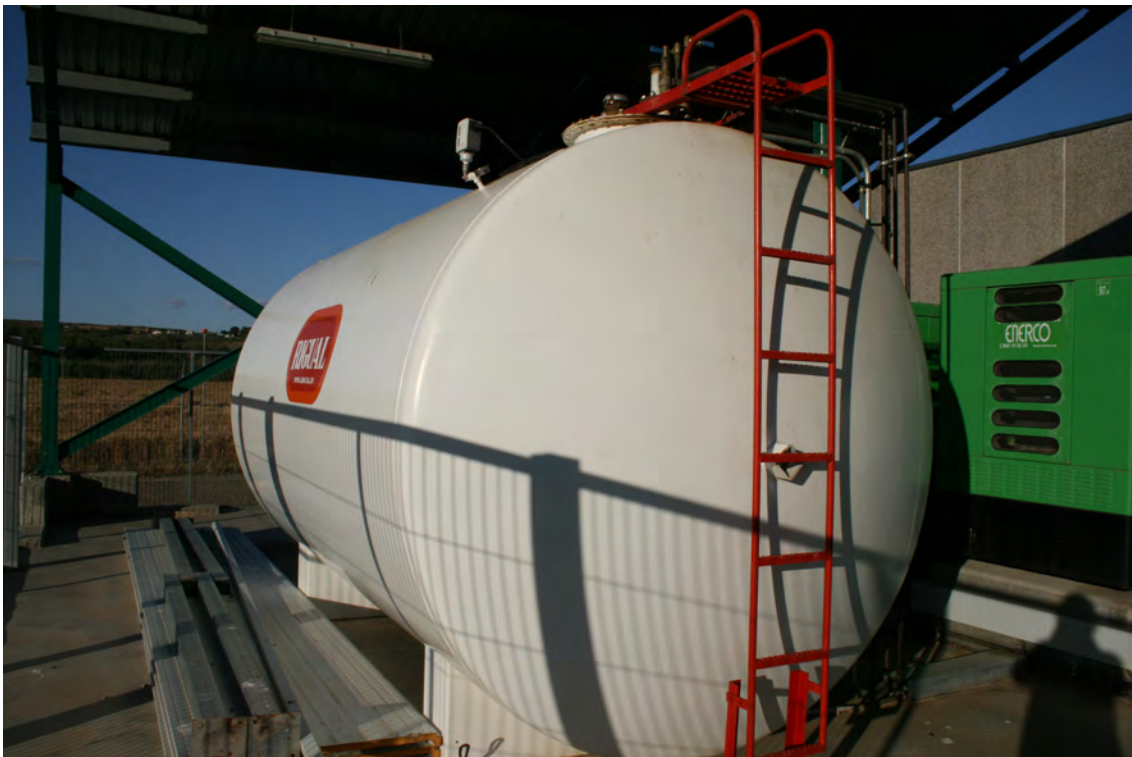
Fig. 8.26 Imagen de depósito de combustible para grupos electrógenos.
