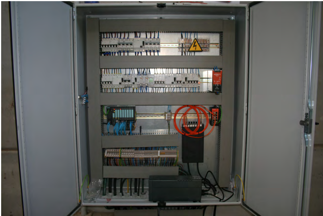
Fig. 8.12 Imagen de armario de control de unidad de filtrado intermedio
