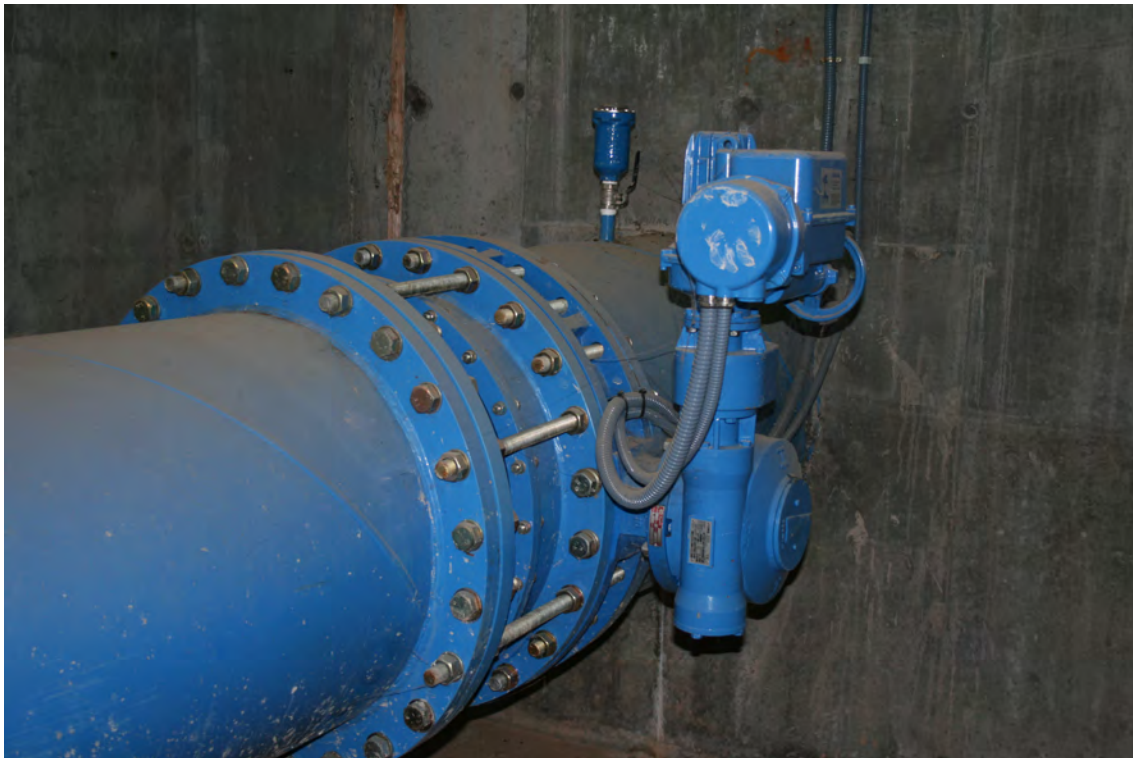
Fig. 8.5 Imagen de válvula motorizada de seguridad en salida de balsa
