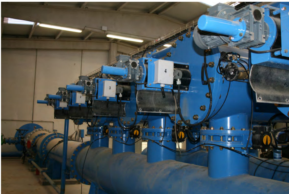
Fig. 8.32 Imagen de accionamientos mecánicos para limpieza de filtros.
