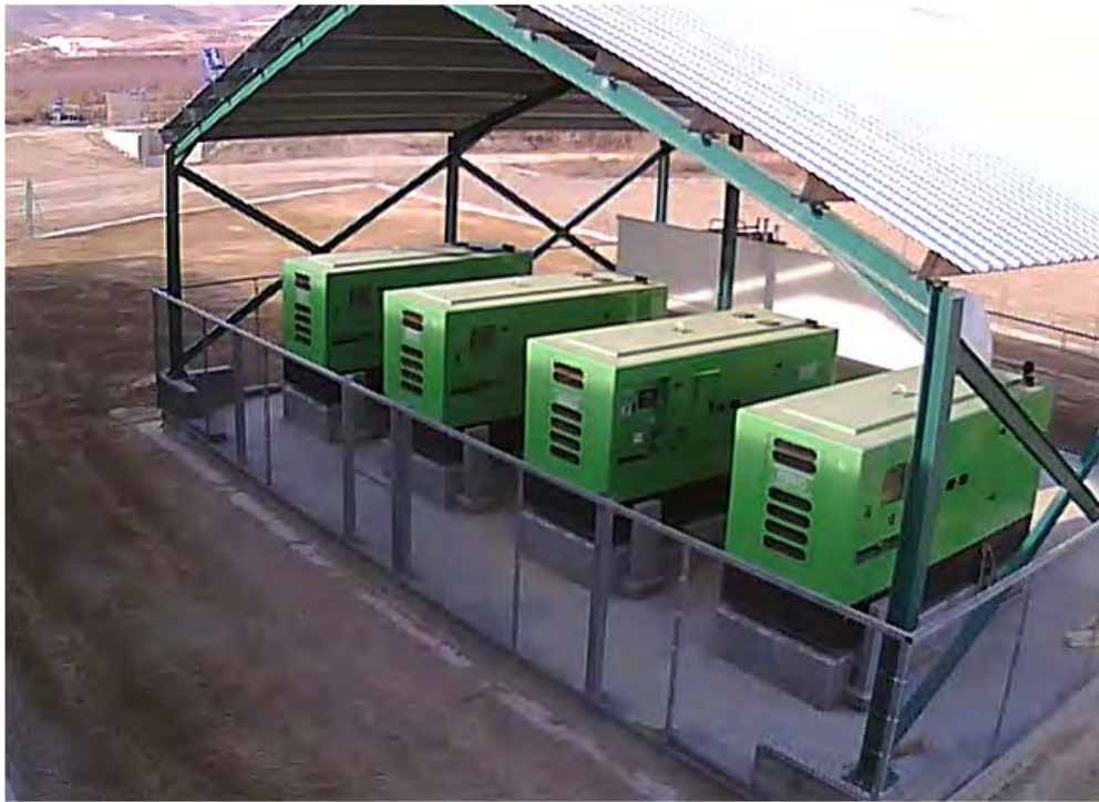
Fig.2.13 Disposición real de grupos electrógenos en planta exterior
