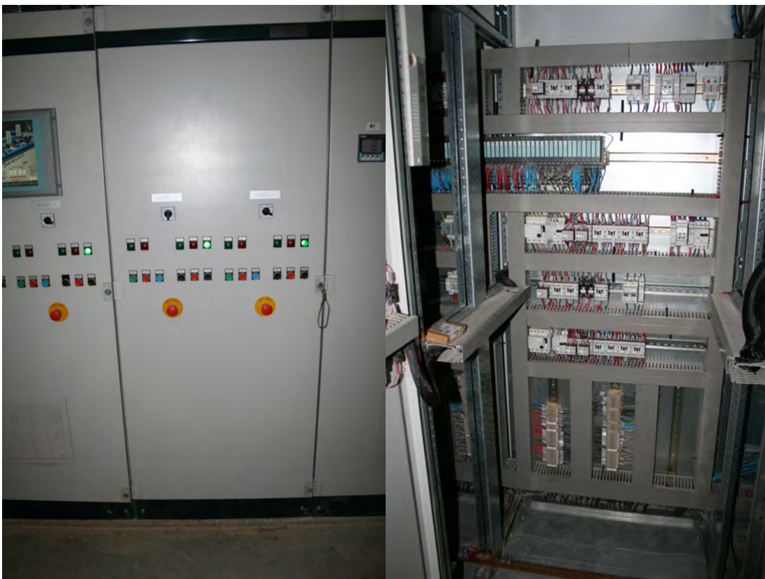
Fig. 8.44 Imagen de módulo de armario de gestión de bombas 3 y 4, y PLC
