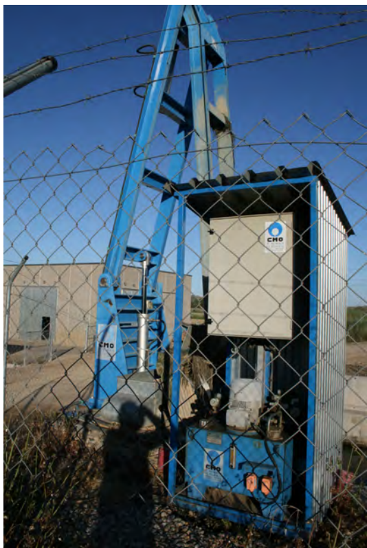
Fig. 8.23 Imagen de armario de control de filtro de reja CMO
