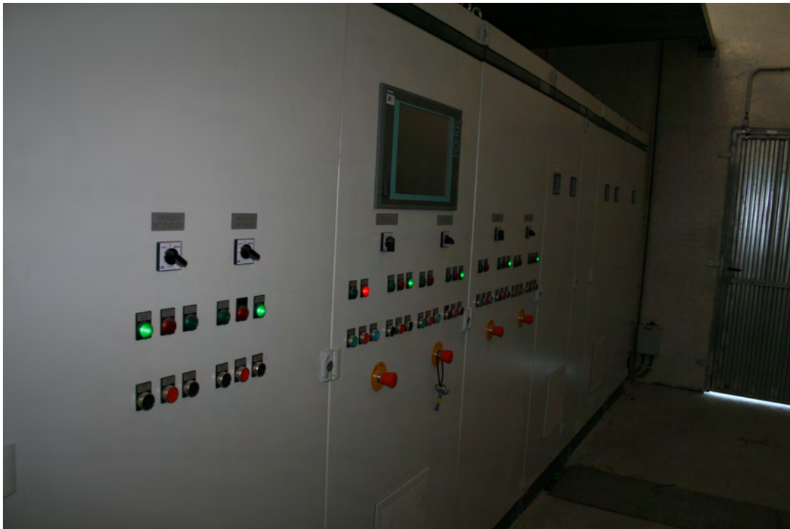
Fig. 8.39 Imagen de frontal de armario eléctrico de potencia y control.
