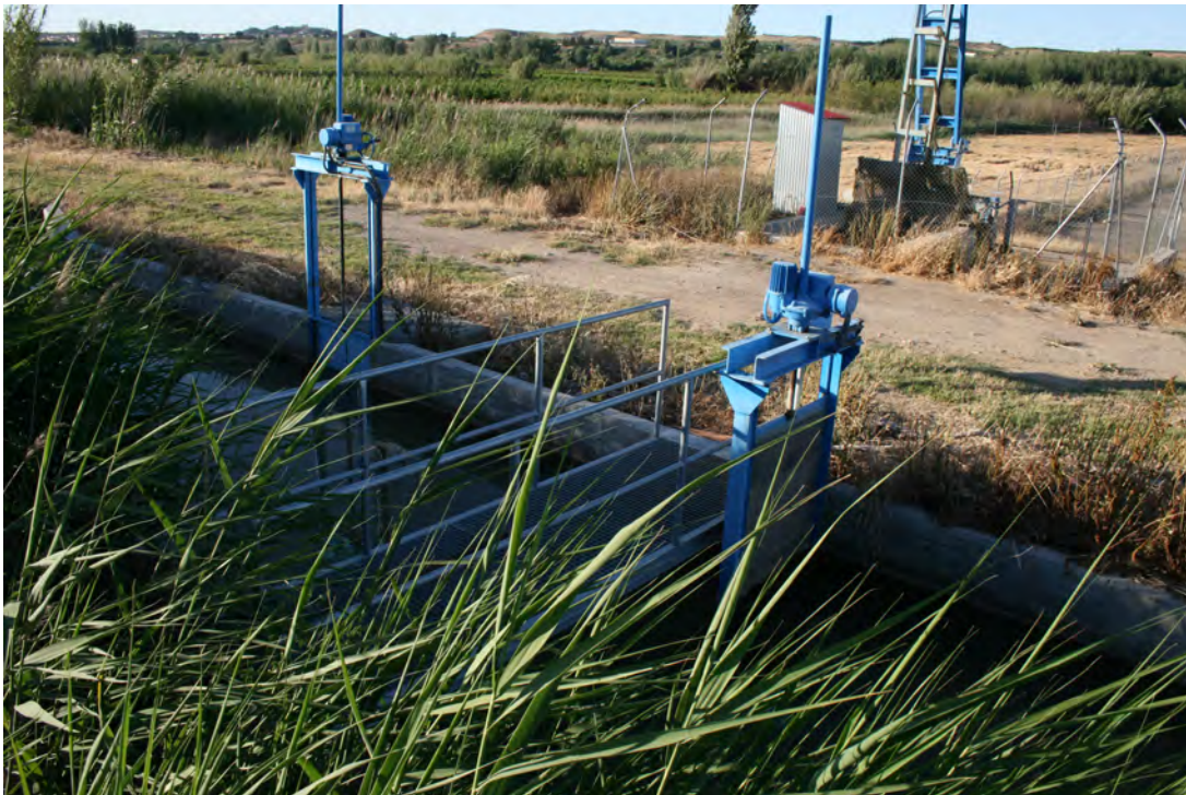
Fig. 8.19 Imagen de válvulas de control de toma y filtro de reja
