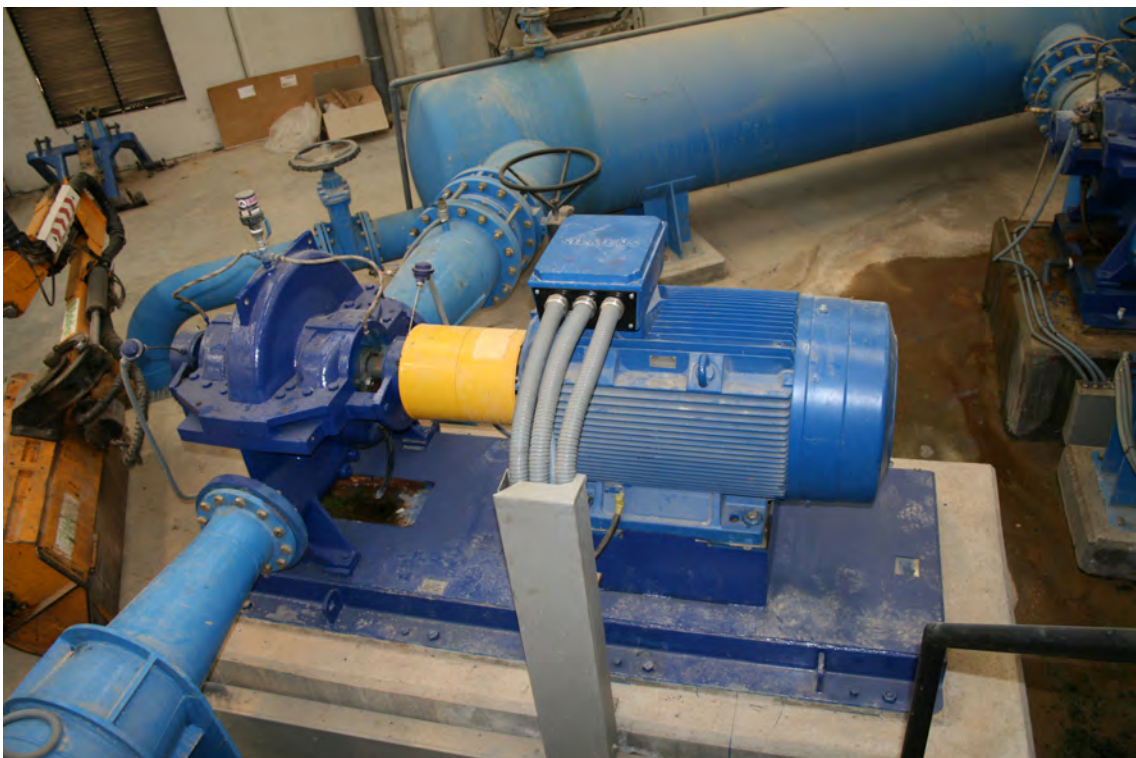
Fig. 8.34 Imagen de unidad de motobomba de impulsión.
