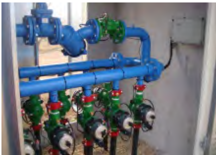
Fig.2.5 Válvulas contadoras en batería Bermad serie 900 y caseta con telecontrol instalado.
