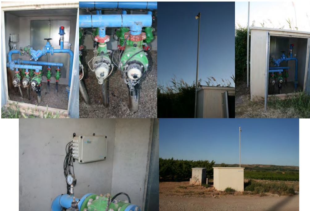
Fig. 8.45 Imagen de unidad de centralización de riego telecontrolado. Detalle de unidad de telecontrol Aquarson
