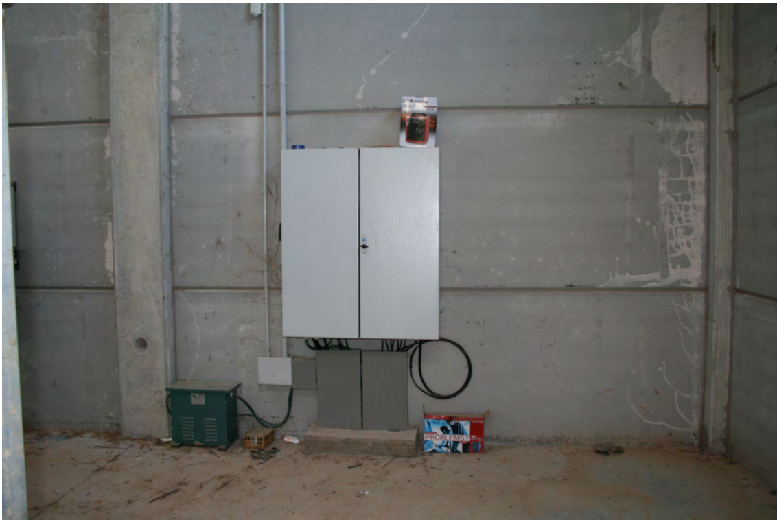
Fig. 8.11 Imagen de armario de control de unidad de filtrado intermedio
