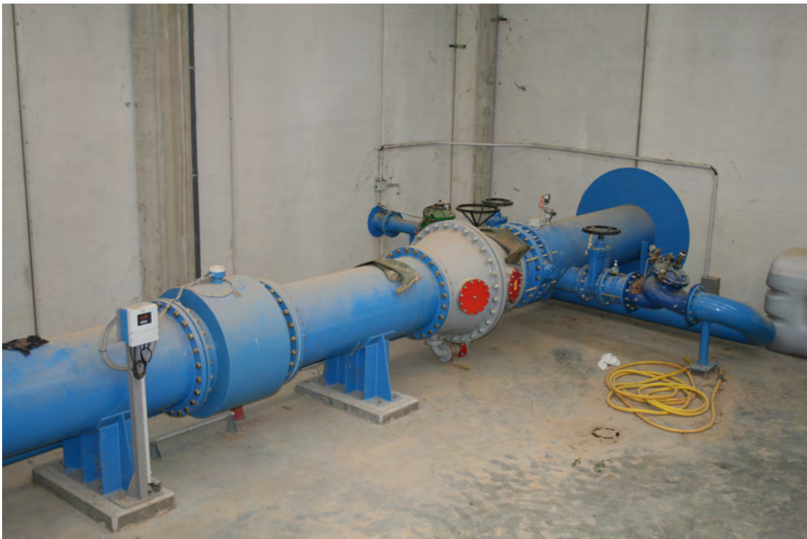
Fig. 8.30 Imagen de válvula antirretorno, valvula hidráulica antiariete, caudalímetro de salida y salida de ramal T7.
