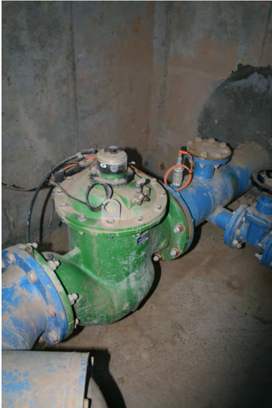
Fig. 8.17 Imagen de válvula contadora y transductor de presión
