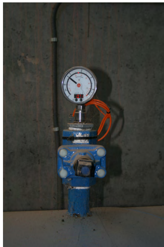
Fig. 8.7 Imagen de transductor de presión para medición de nivel de balsa
