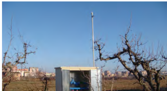
Fig.2.5 Válvulas contadoras en batería Bermad serie 900 y caseta con telecontrol instalado.
