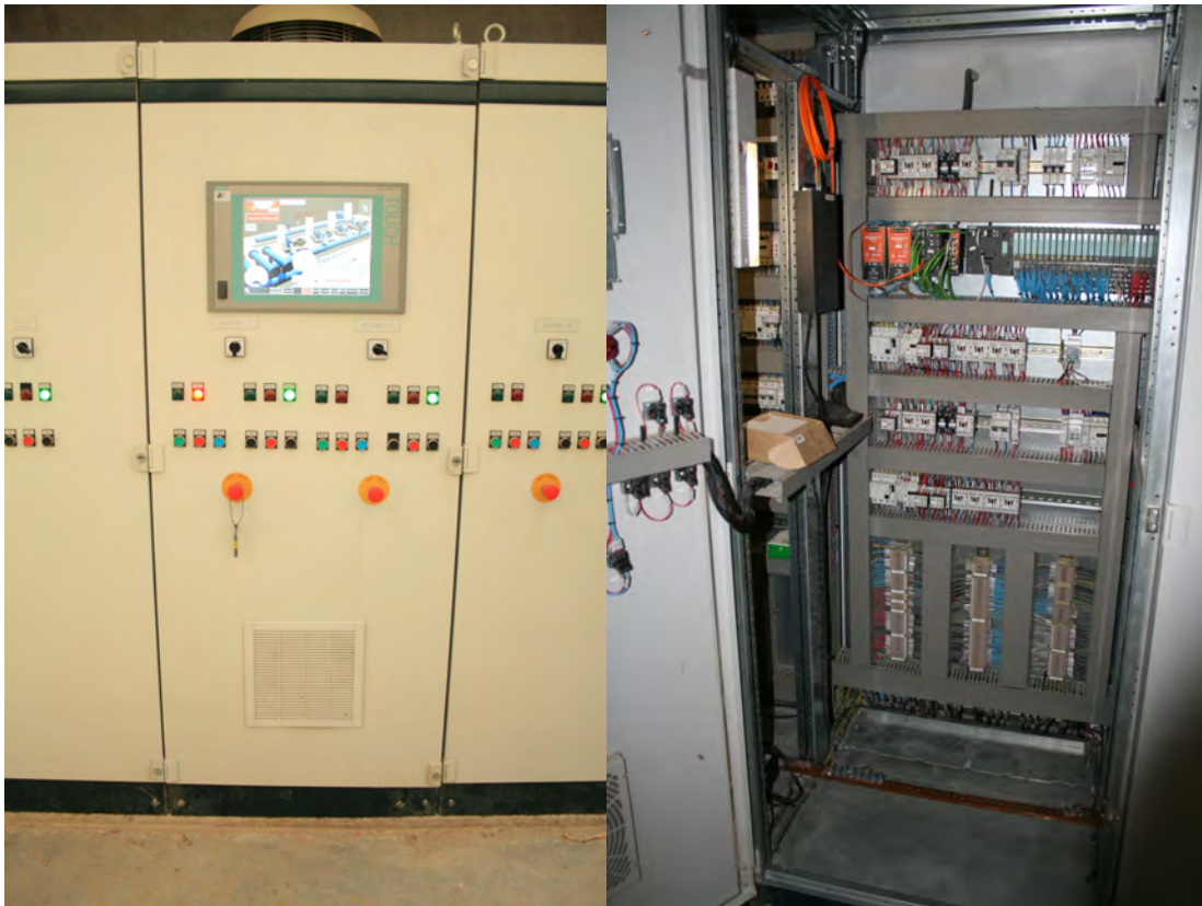
Fig. 8.41 Imagen de módulo de armario de gestión de bombas 1 y 2, comunicaciones, PLC y pantalla deSCADA-HMI
