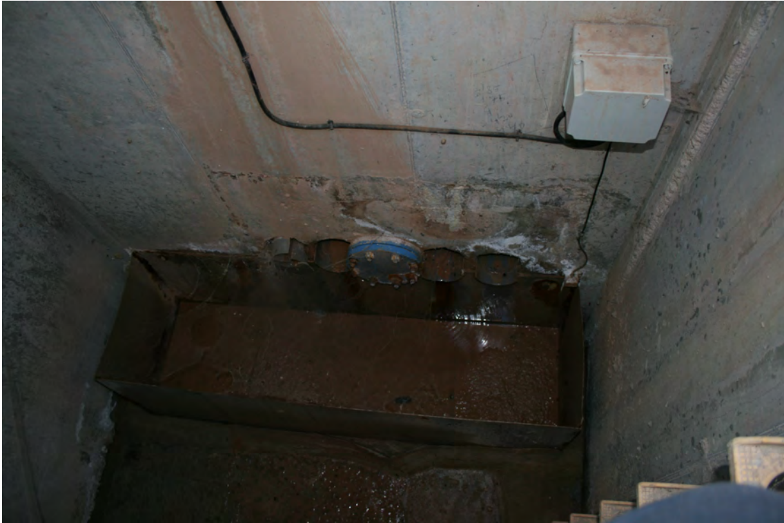
Fig. 8.8 Imagen de arqueta de control de drenaje de lámina. Detección por electrodos.
