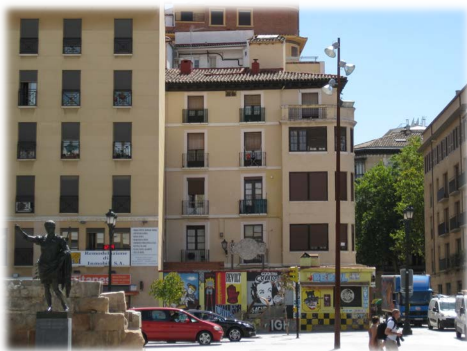
Foto actual de la calle Manifestación, antigua ubicación de la puerta
