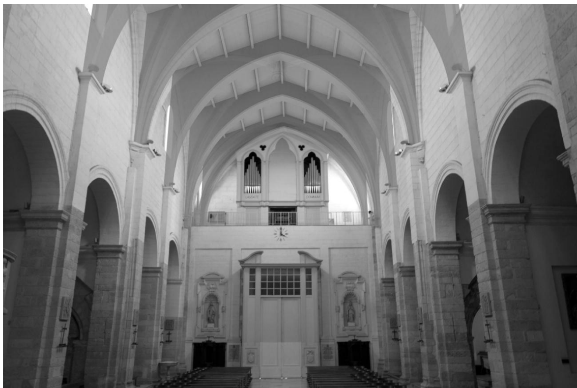
Fig. 4. Sassari. Catedral de San Nicola. Nave. Reconstrucción de la anterior cubierta de madera con arcos diafragma. [Reconstrucción gráfica: Federico Maria Giammusso]
