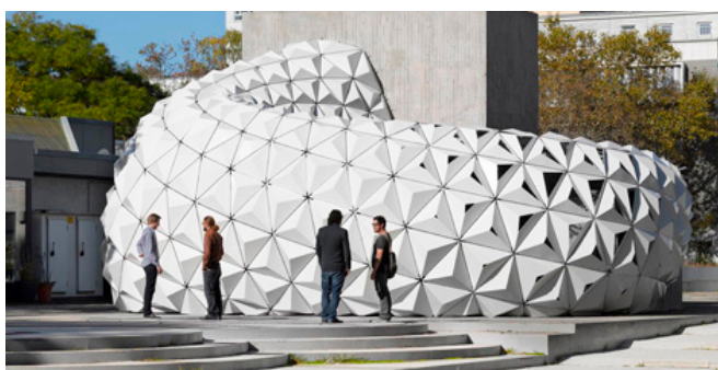
Fig. 22 - “ArboSkin - fachada de bioplástico” desarrollado por el Institute of Building Structures and Structural Design (ITKE) de la Universidad de Stuttgart - Alemania (2013)
