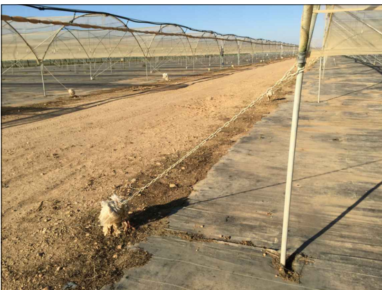
5 Sujeción exterior de seguridad de los vanos extremos mediante cadenas.
