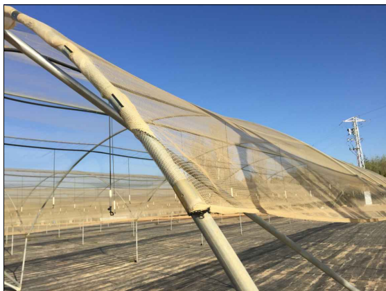
6 Tensado de la malla antigranizo y sujeción a los arcos mediante abrazaderas metálicas.
