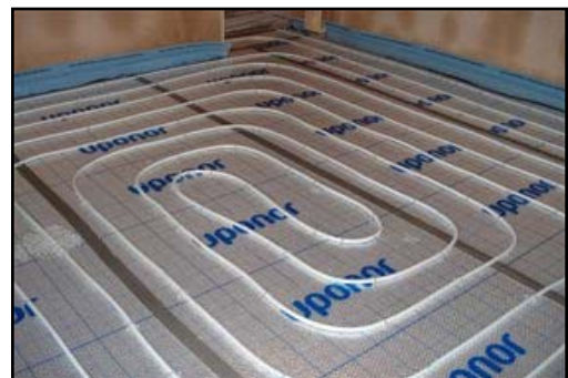
Ilustración 28 – Climatización por suelo radiante/refrescante
