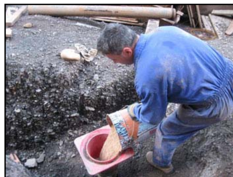
Ilustración 22 – Relleno de la perforación
