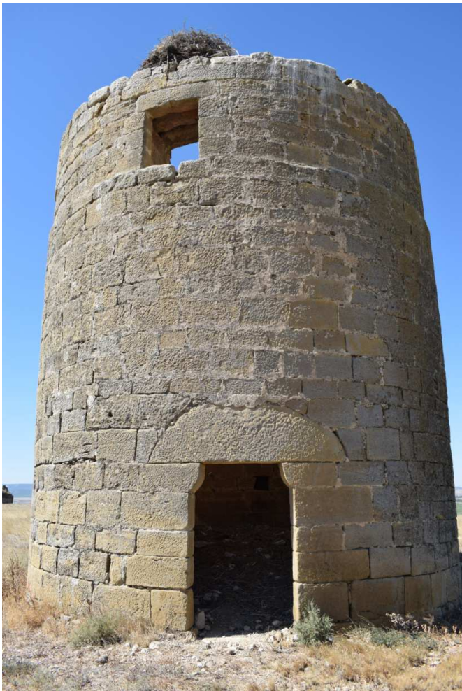
Figura 82. Torre sur. Cuenta con una puerta de gran tímpano apoyado sobre dos modillones. Sobre ella, y descentrado, se abre un vano cuadrado
