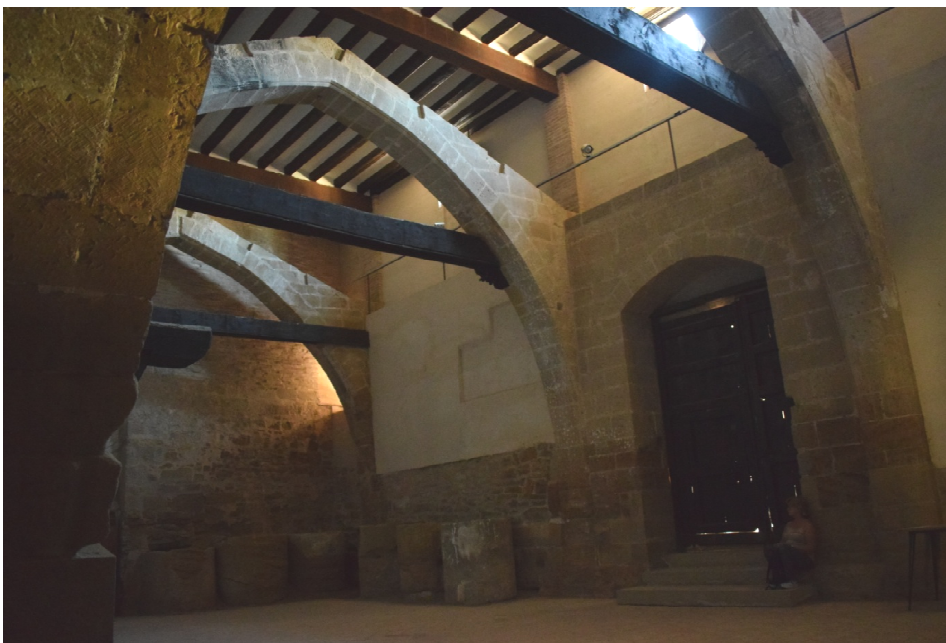
Figura 21. Interior del vestíbulo previo al claustro. Las tres arcadas apuntadas quedaron sin función tras las ampliaciones y el recrecimiento en altura del siglo XVII. Actualmente la sala está dedicada a conferencias, proyecciones...
