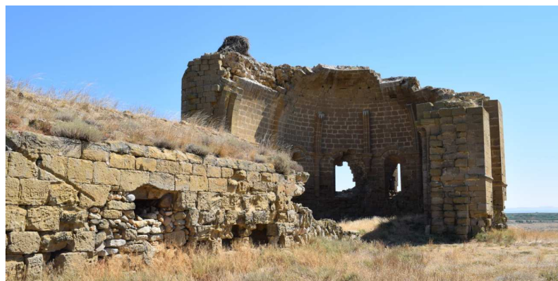
Figura 75. Vista general de la iglesia inconclusa.
