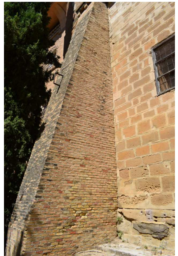
Figura 9. Contrafuertes diseñados por Ricardo Magdalena. Destinados a frenar deterioro de la fachada de la iglesia.
