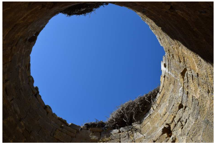
Figuras 84, 85 y 86. Interior de la torre sur. Destaca la gran mella que recorre parte del perímetro del muro, indicando su posible uso como molino. Dos nidos de cigüeña comprometen su conservación.
