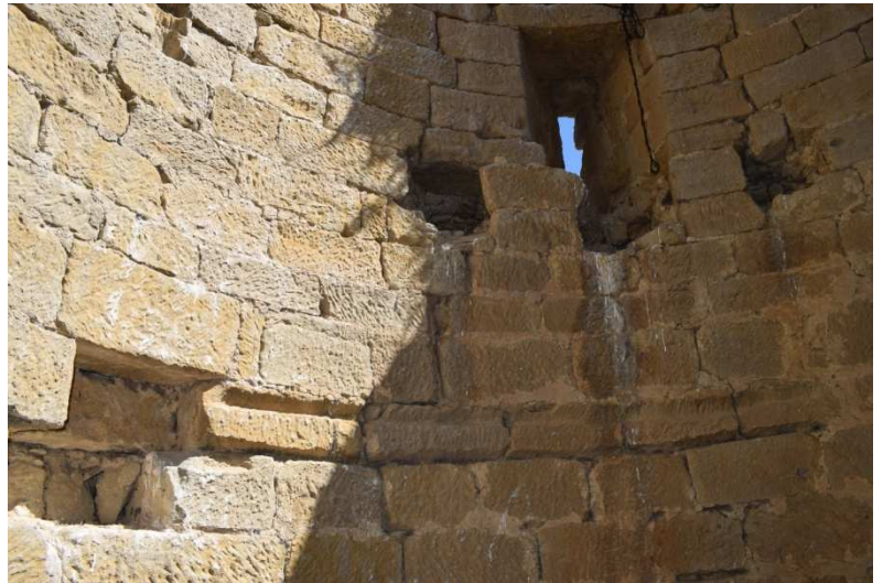
Figuras 88 y 89. Interior de la torre norte.
