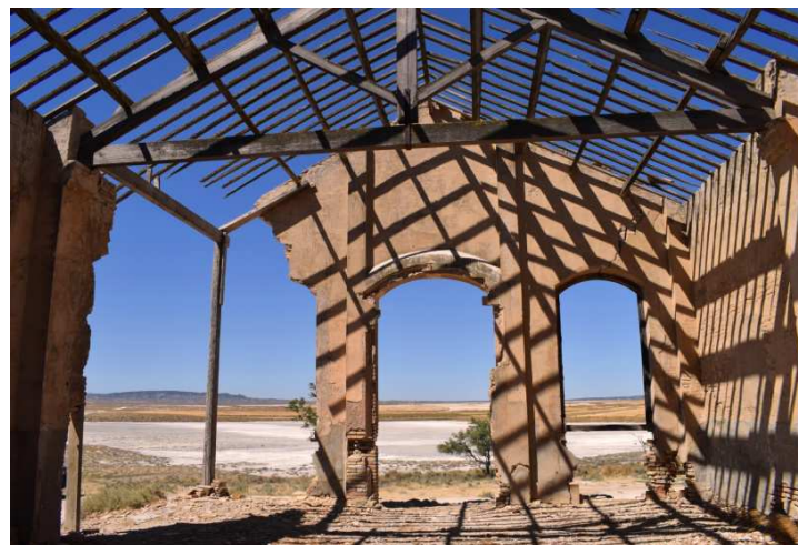
Figura 120. Almacén de La Sulfúrica . Interior.
