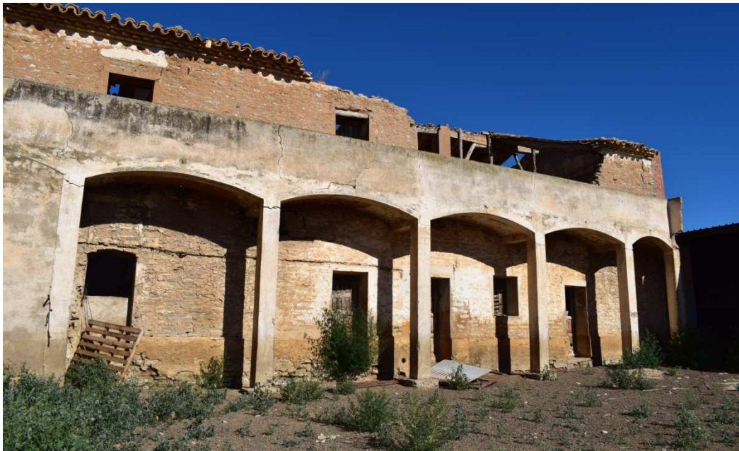
Figura 113. Viviendas provisionales, ala norte.
