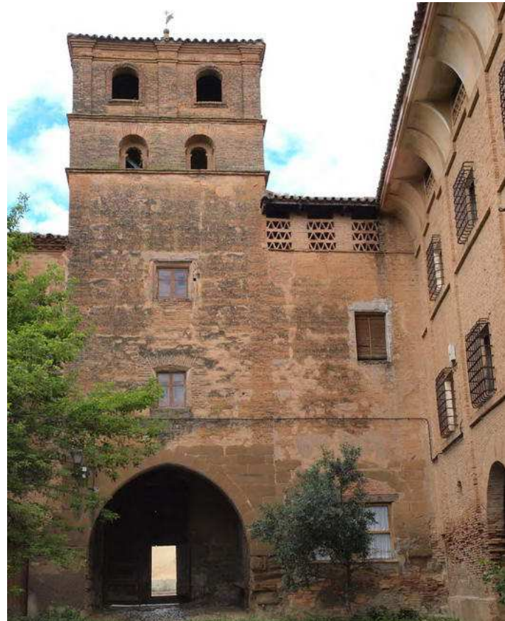
Figura 2. Torre del homenaje y acceso principal. A cada lado del corredor de entrada se situaban la garita de guarda y la cárcel, utilizada como tal hasta el franquismo. La muralla, además de por su valor defensivo, servía para reafirmar la división entre el mundo terrenal exterior y el mundo divino del interior.
