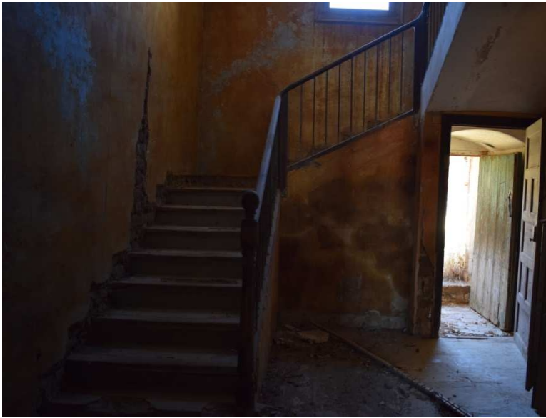
Figura 101. Escaleras casa residencial de INC.
