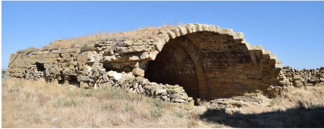
Figura 58. Nave de la iglesia inconclusa
