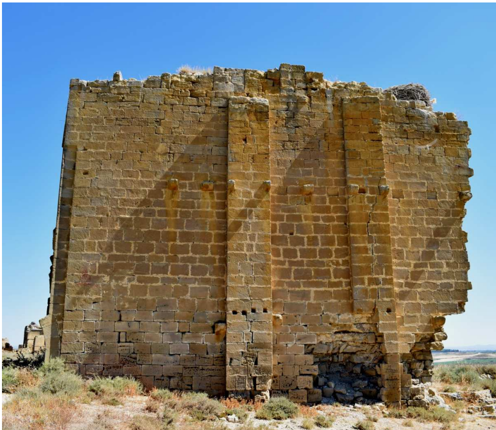
Figura 51. Vista lateral de la iglesia volada.
