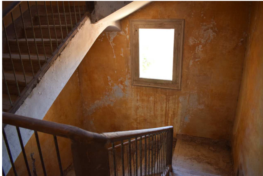
Figura 104. Casa residencial del INC. Escaleras.
