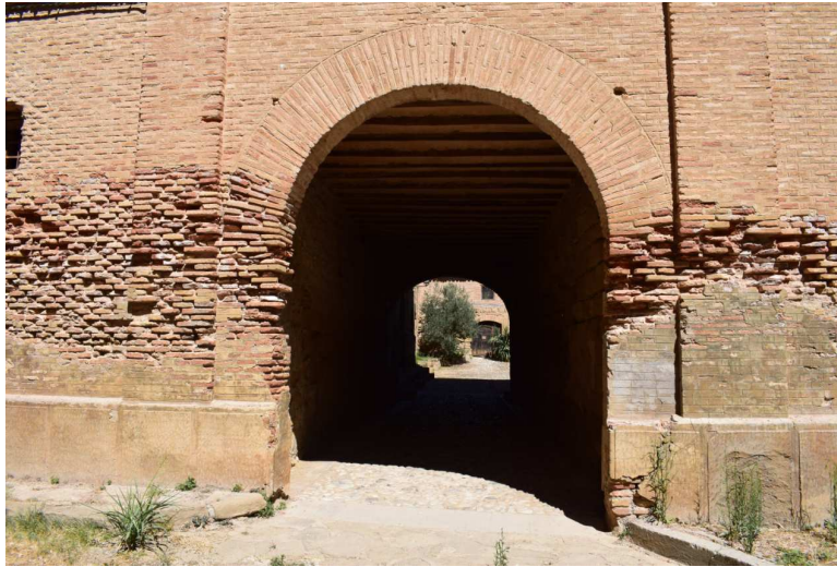
Figura 10. Paso adintelado hacia el segundo patio desde la entrada.
