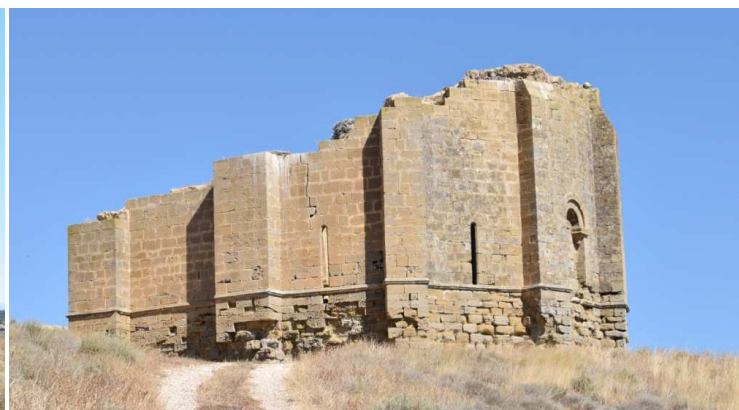
Figura 76. Cabecera de la iglesia inconclusa.
