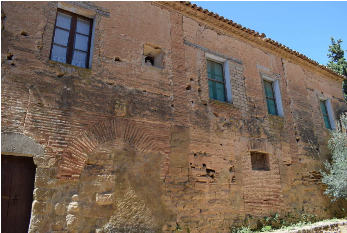
Figura 17. Detalle de la fachada de las dependencias masculinas. Con la Contrarreforma y la separación de sexos dentro del monasterio, se construyeron nuevas dependencias para los hombres apoyadas en la muralla medieval, frente al pórtico del vestíbulo, al este. Estas casas se construyeron bajo el gobierno de la abadesa Porquet, tal y como atestigua el escudo que corona el arco cegado del primer término.
