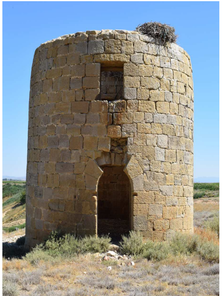
Figura 83. Torre norte. La puerta de la torre norte es de medio punto dovelado, con un segundo vano cuadrado descentrado. En ella, las últimas hiladas son de diámetro descendente, como si fuese el comienzo de una falsa cúpula.
