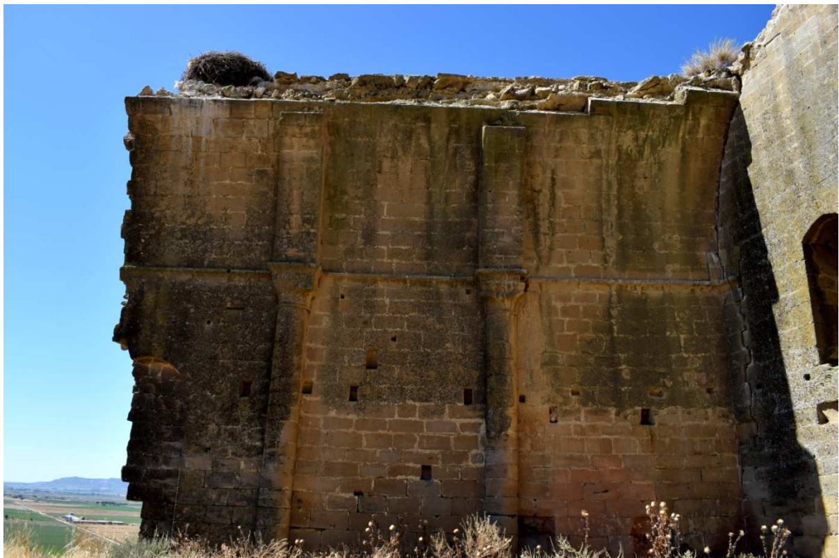
Figura 53. Interior de la iglesia volada. Muro norte. Se conservan dos únicas semicolumnas, rematadas por capiteles de cimacios decorados que sostienen los arcos fajones de la bóveda.
