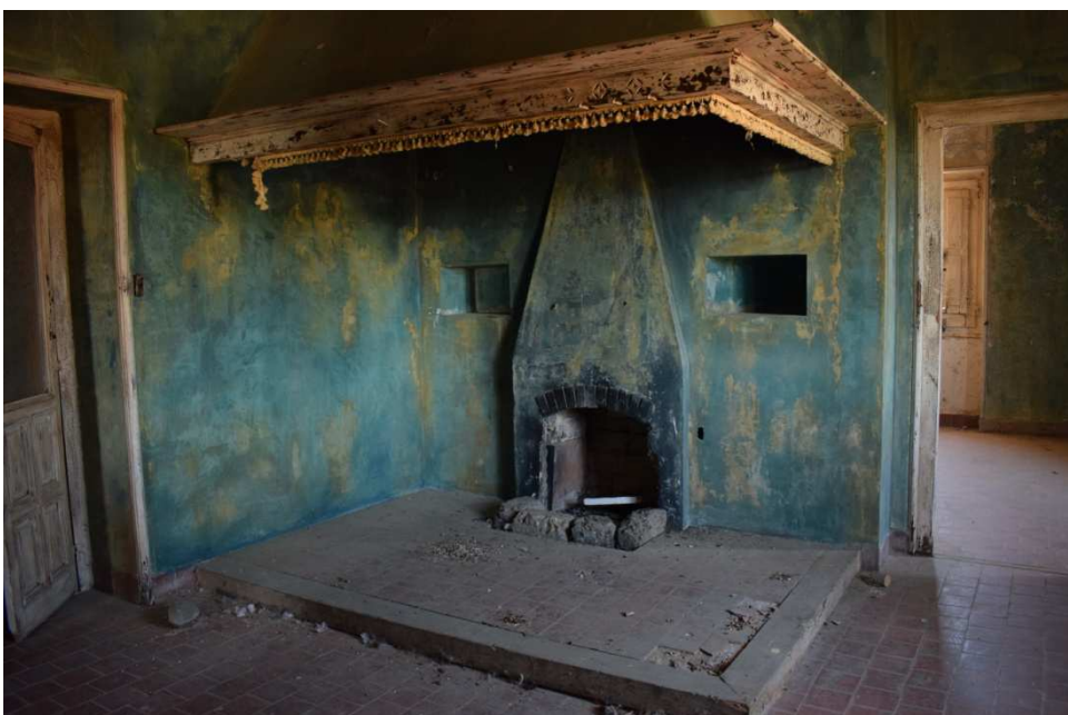
Figura 106. Casa residencial de INC, planta noble. Destaca la habitación con chimenea, con paredes de color azul, siendo las del resto de la casa amarillas o blancas. El resto de las habitaciones están vacías, y algunas presentan tabiques completamente derribados o en gran deterioro. Se corresponde esta sala con la casa de Leonardo.
