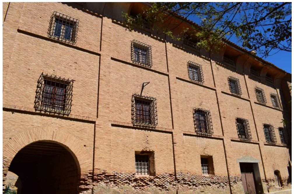
Figura 3. Fachada exterior del palacio de la abadesa (s.XVIII).
