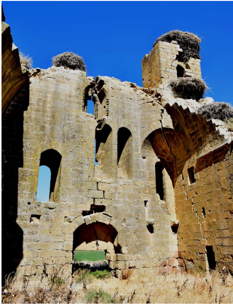
Figura 52. Interior de la iglesia volada. Se aprecia la irregularidad en la distribución de los vanos. Destaca la torre en el ángulo derecho, a la que se accedía a través de una escalera de caracol.
