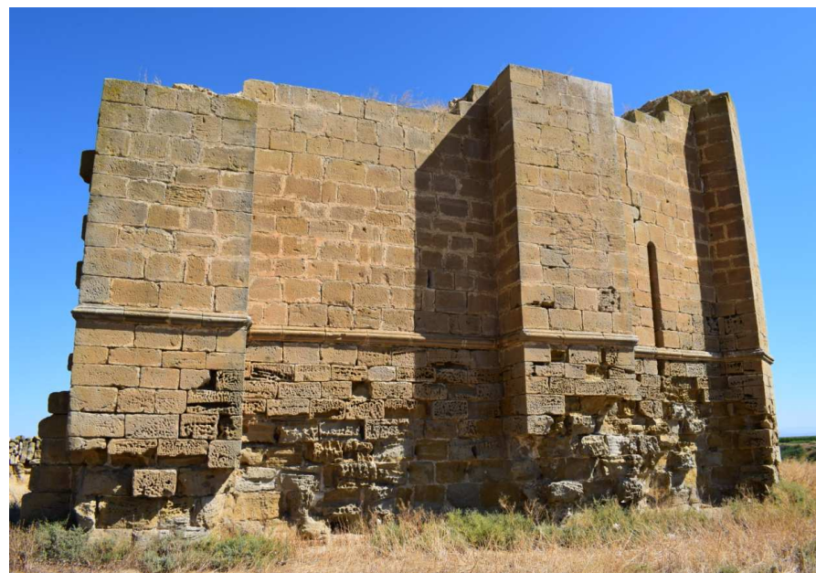
Figura 73. Exterior de la cabecera, iglesia inconclusa. Los potentes contrafuertes sostendrían la cubierta abovedada.
