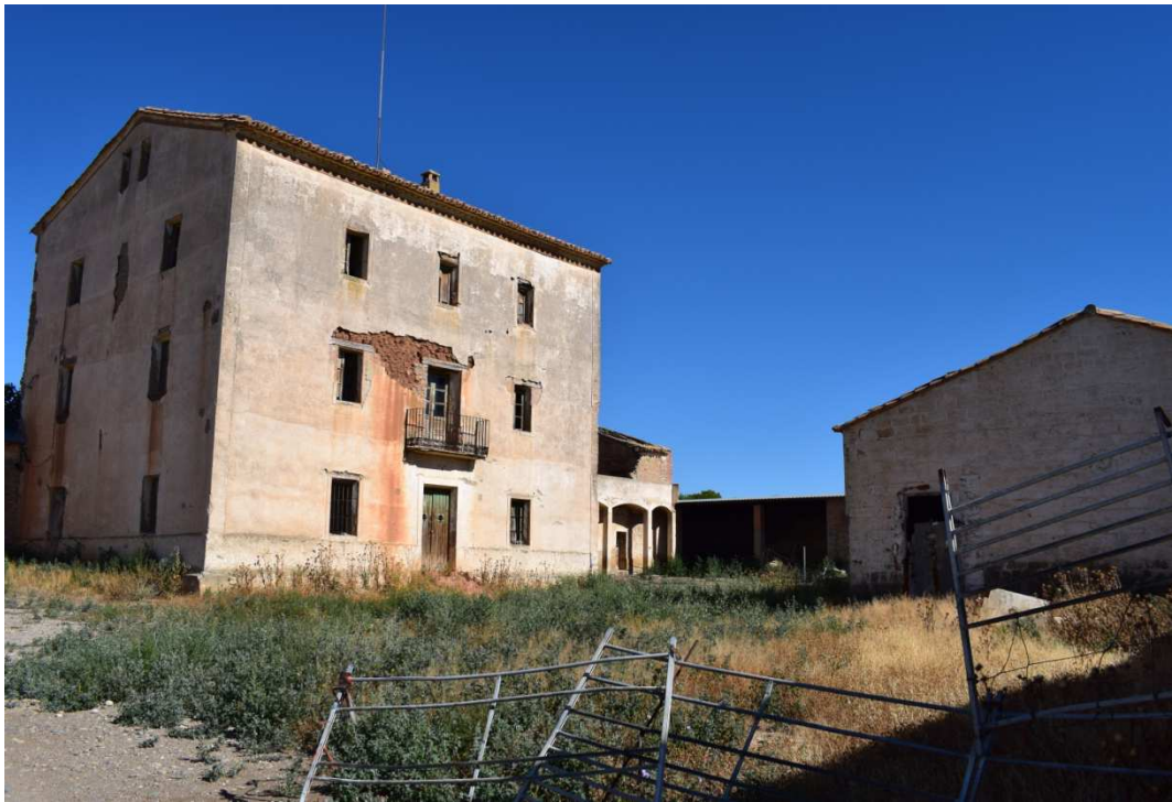
Figura 91. Vista general de la finca con la Casa Bellido o residencia del INC en primer lugar.
