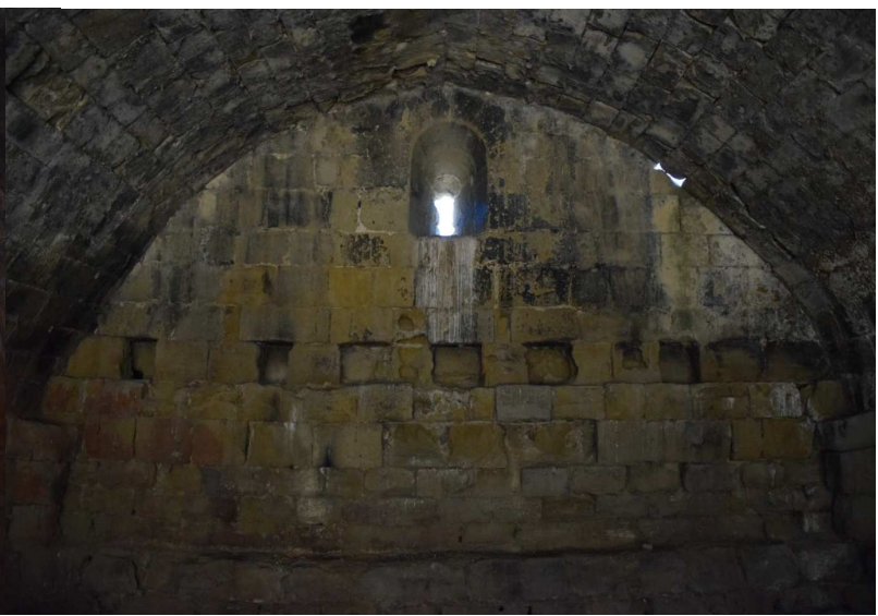
Figura 60. Muro oeste de la iglesia inconclusa.
