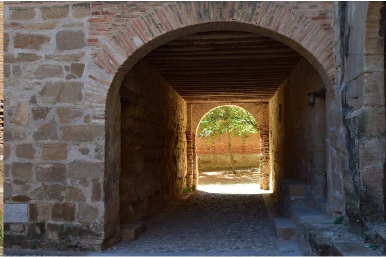
Figura 11. Paso adintelado desde el patio. Se aprecia a su derecha un pequeño apoyo para facilitar la subida y bajada a las caballerías.
