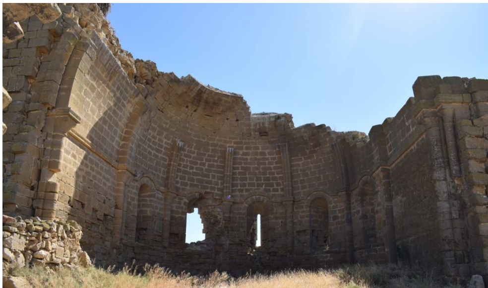
Figura 65. Cabecera de la iglesia inconclusa. Los nervios triples que sostienen la bóveda muestran lo adelantado de su técnica, así como la decoración de los capiteles, más avanzada.
