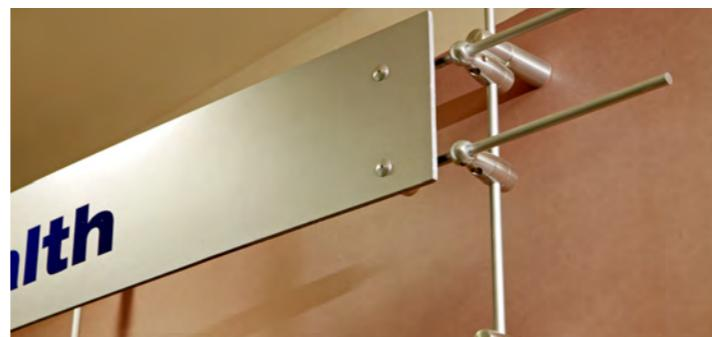
Este hecho provoca que los anclajes deban quedar a cara vista o, en su defecto, cubiertos por algún tipo de plancha que va encajada sobre el otro soporte, aumentando así el número de piezas necesarias para un único elemento de señalética.
