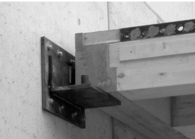
Fig. 54. Conexión núcleo-panel híbrido (Kaufmann, 2012)
