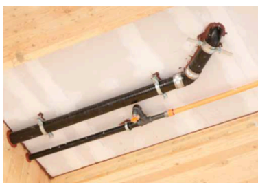
Fig. 111 Instalación de sprinkler (Canadian Wood Council, 2015).
