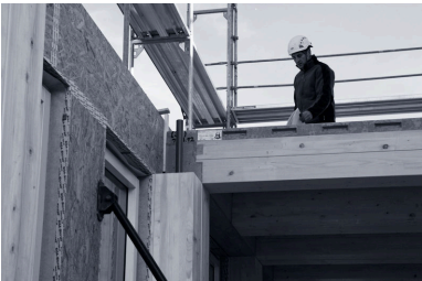
Fig. 53. Conexión columna-panel híbrido (Architekten Hermann Kaufmann ZT GmbH, 2016)
