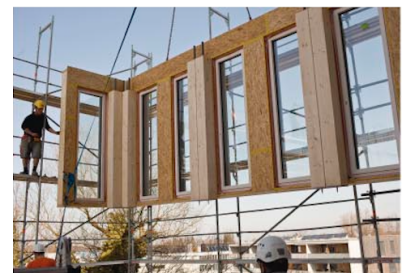
Fig. 58. Panel fachada de esquina (Tectónica online, 2013).
