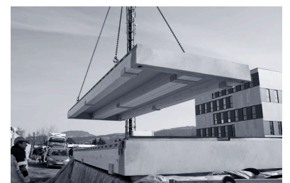
Fig. 59. Panel fachada de esquina (Architekten Hermann Kaufmann ZT GmbH, 2016).
