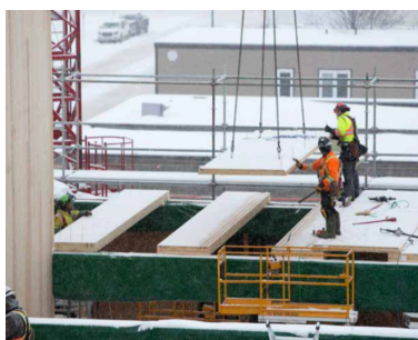
Fig. 109 Instalación de suelos CLT (Binational Softwood Lumber Council, 2015).
