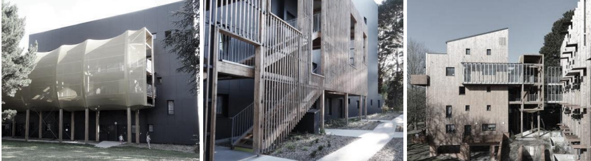
018 | Corredores y pasarelas de Gran Carcouët. a) Corredor norte b) Corredor sur c) Pasarela de comunicación entre edificios
