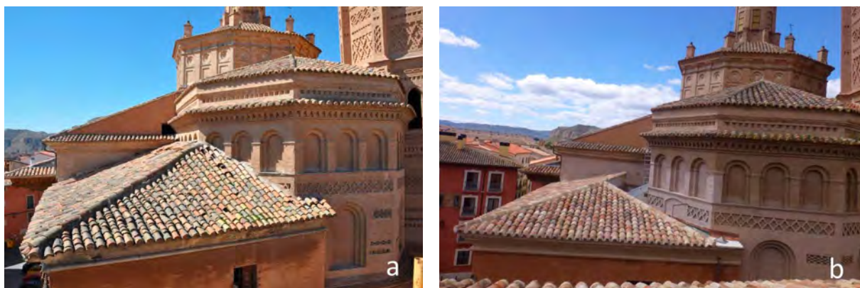
Figura 10. Cubierta. a) Estado inicial; b) Estado final.
