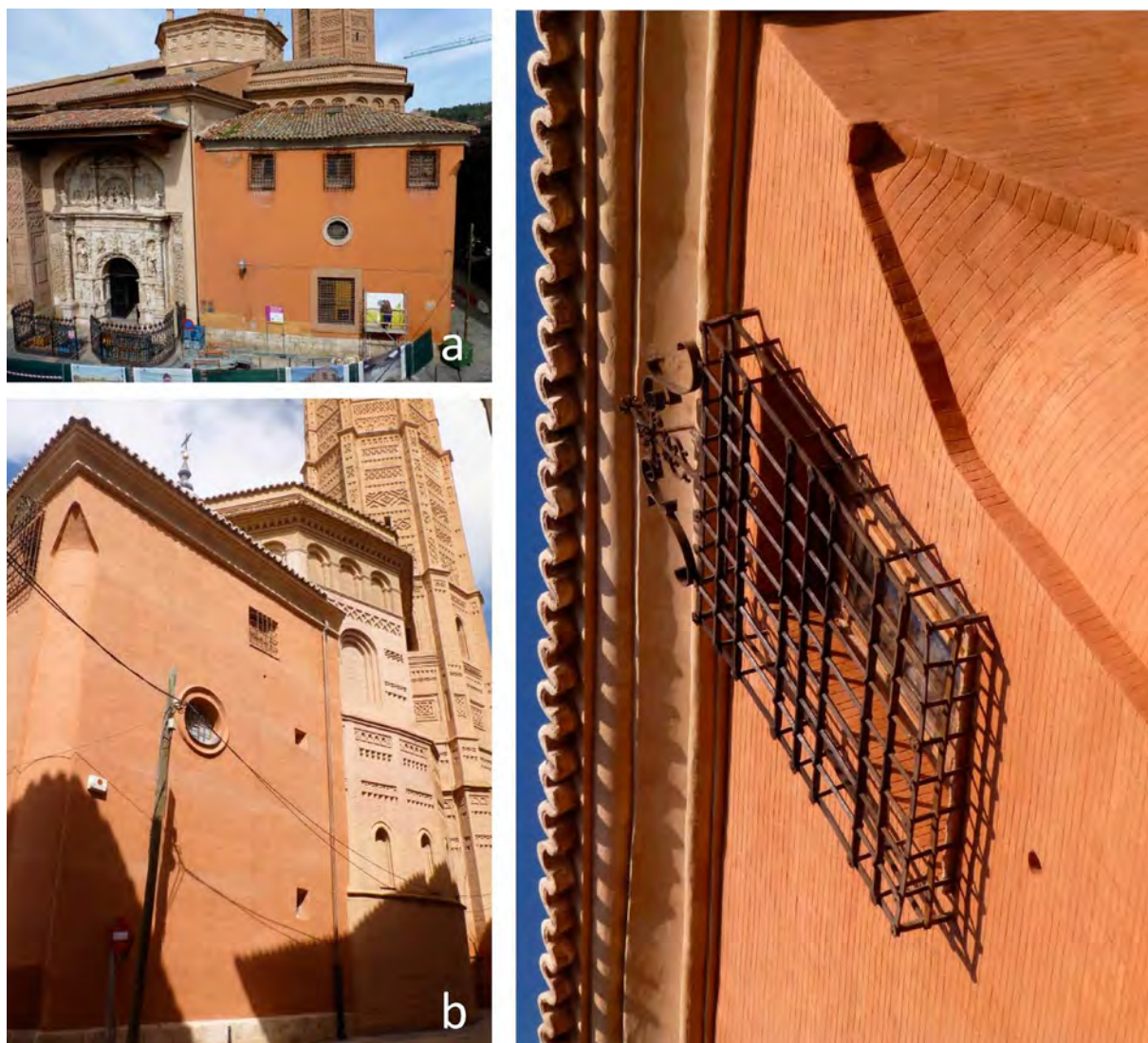
Figura 11. Fachada de la sacristía. a) Estado inicial; b) Frente occidental, tras su restauración; c) Detalle de la obra ejecutada.
