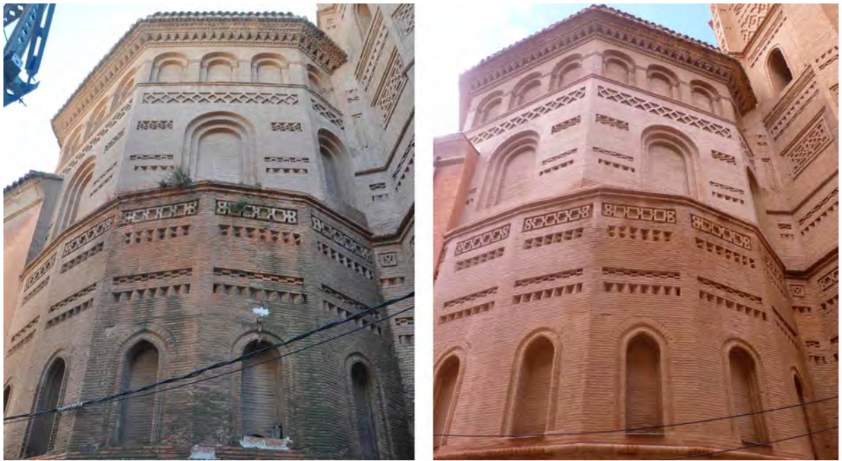
Figura 3. Ábside. a) Estado inicial; b) Estado, a la finalización de las obras.
