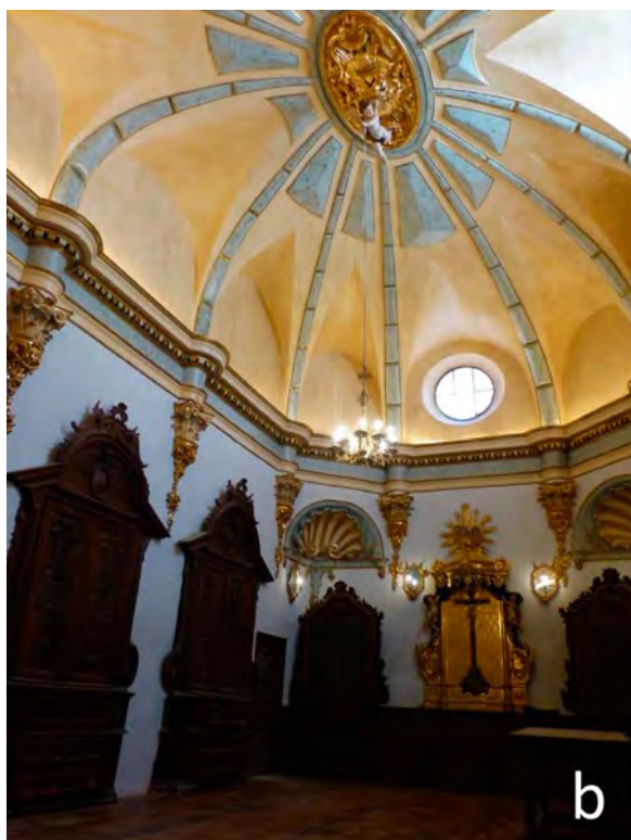
Figura 12. Interior de la sacristía. a) Estado, al comienzo de las obras; b) Estado final, una vez reintegrado su cromatismo original.
