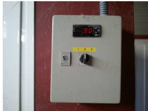
Figura 5.17 "Controlador de humedad de la cámara húmeda"
