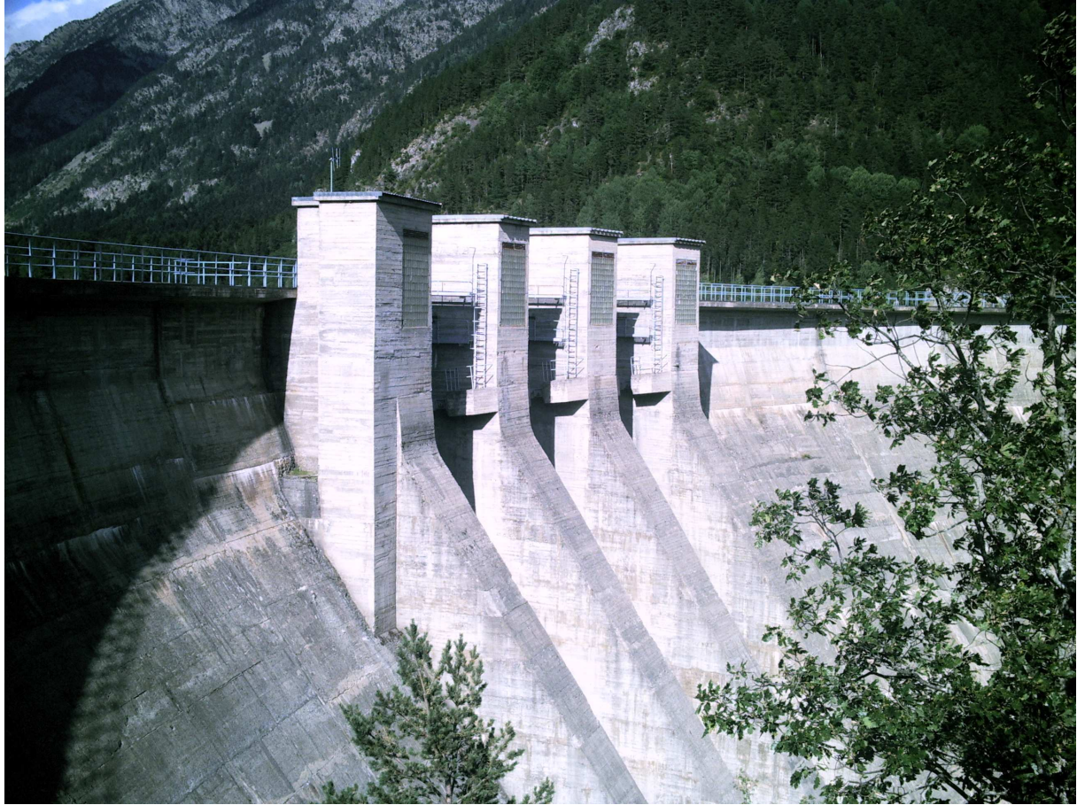
Foto 5: Aliviaderos de superficie de la Presa de Paso Nuevo. Benasque (Huesca)
