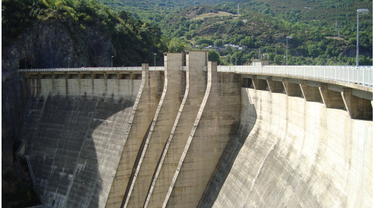
Foto 3: Presa de arco-gravedad del embalse de Búbal. Valle de Tena (Huesca).
