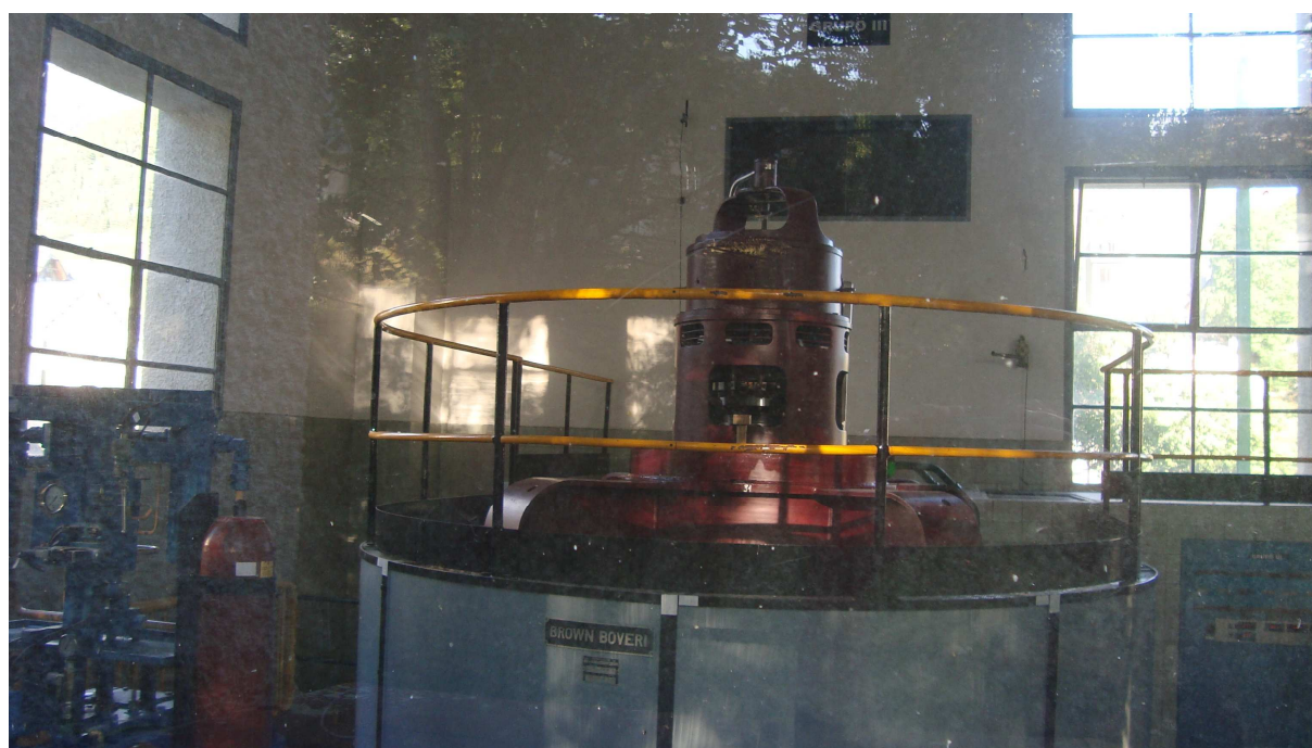
Foto 18: Turbina Francis de la Central de Sallent (Huesca), puesta en servicio en 1954.
