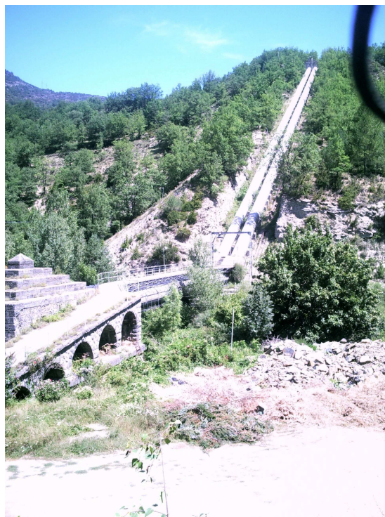
Foto 9: Tubería forzada de la central de Seira (Huesca).
