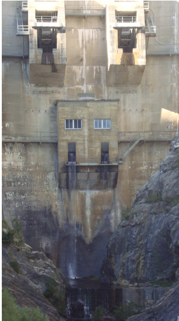
Foto 6: Vista exterior de los desagües de la Presa de Lanuza (Huesca).
