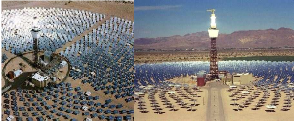
Figura 31. Heliostatos según disposición circular.
