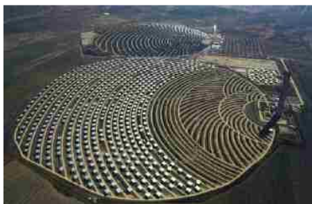
Figura 28. Central de torre central
