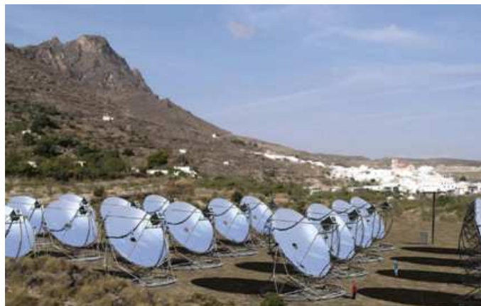
Figura 27. Plantación térmica solar de dispositivos de disco Stirling
