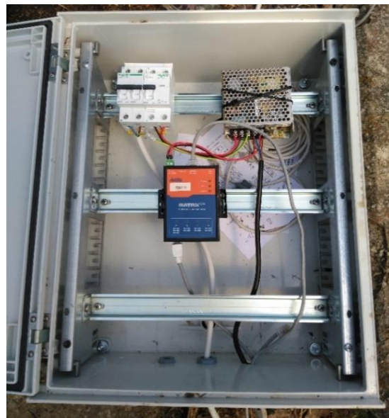
Figura 33. Caja hermética que contiene el ordenador de campo (Matrix 504) para la recogida de datos (Fuente: Elaboración propia).
