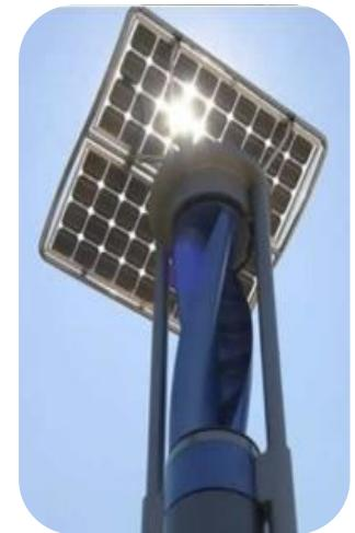
**Sistema de iluminación híbrido** instalado en Cánada. Las farolas llamadas “**Kazekamome Remote Hybrid**” poseen un sistema de alimentación eléctrica que proviene tanto del sol como del viento.
