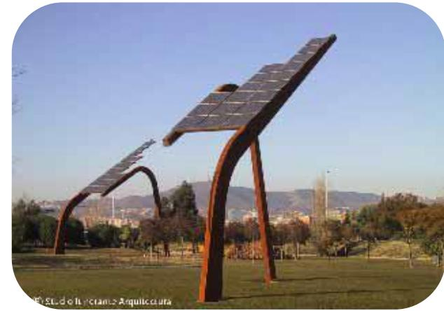
“**Dinosaurio**”. Planta generadora. Creada por SIARQ, genera hasta 3.800 kWh anuales. Toda la energía obtenida se transfiere a la red eléctrica; mientras que la energía consumida por los proyectores se obtiene directamente de la red de distribución eléctrica convencional.
