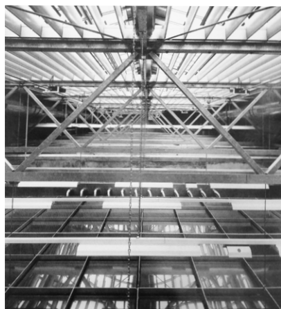
Fig. 64 - Cercha interior de la cubierta de la sala de exposiciones. Filtro de luz.
