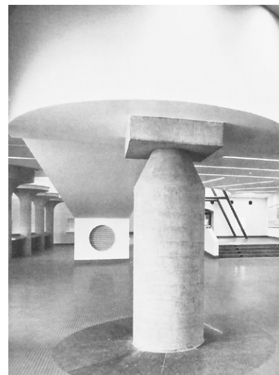
Fig. 73 - Columna de apoyo de la rampa.
