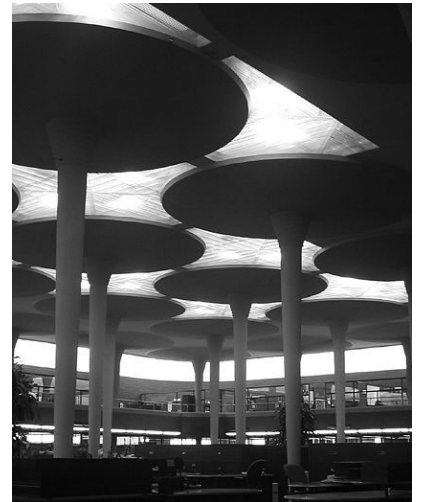
Fig. 52 - Pilares en el edificio Johnson Wax, Frank Lloyd Wright.
