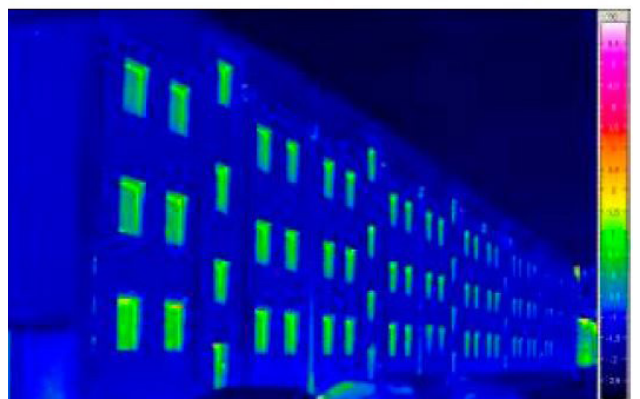
Fig. 21-22_ Vivienda en Teverstrasse, Frankfurt (Alemania). Después de la rehabilitación enerphit.
