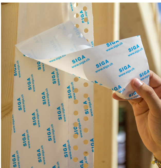
Fig. 70_ Colocación de cintas de estanqueidad en la cabaña pasiva del Santuario de Borja. Fast Wood Festival '17.
