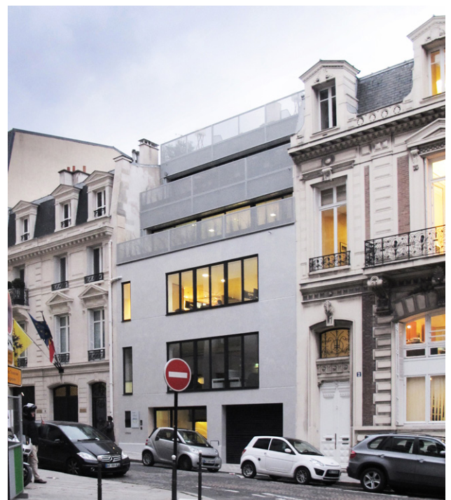
Fig. 49_ Réaménagement de bureaux et création d'un duplex en surélévation. Descombes-Thieulin.
