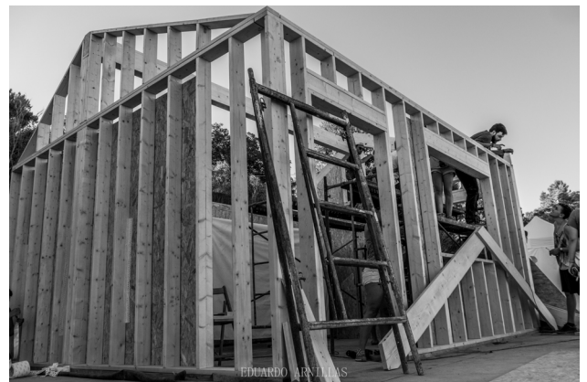
Fig. 40_ Cabaña passivhaus construida en el Fast Wood Festival IV
