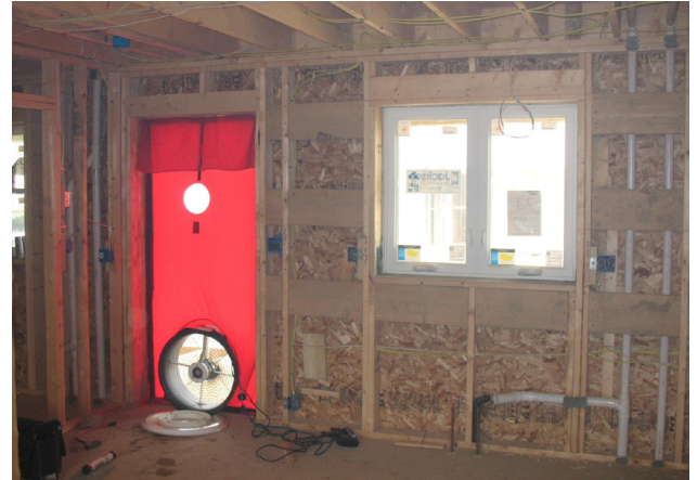
Fig. 25_ Test de blower-door. Prueba que se realiza en las viviendas al menos dos veces, una durante la ejecución para localizar posibles fallos y otra al finalizar para certificar que el valor de la hermeticidad esta por debajo de 0,6. Una vivienda unifamiliar de unos 150 m 2 en Zaragoza ronda los 5,1 6 .
