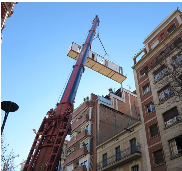
Fig. 33_ Proceso constructivo de La Casa por el Tejado, LCT.
