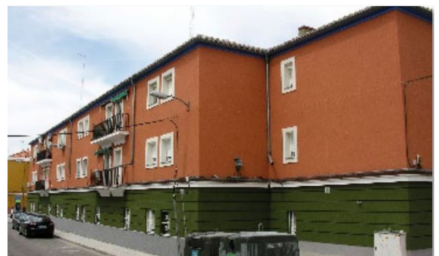
Fig. 38-39_ Rehabilitación con SATE, antes y después.
