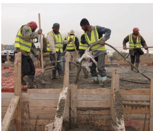
[Fig. 45] Instalación de letrinas comunes.
