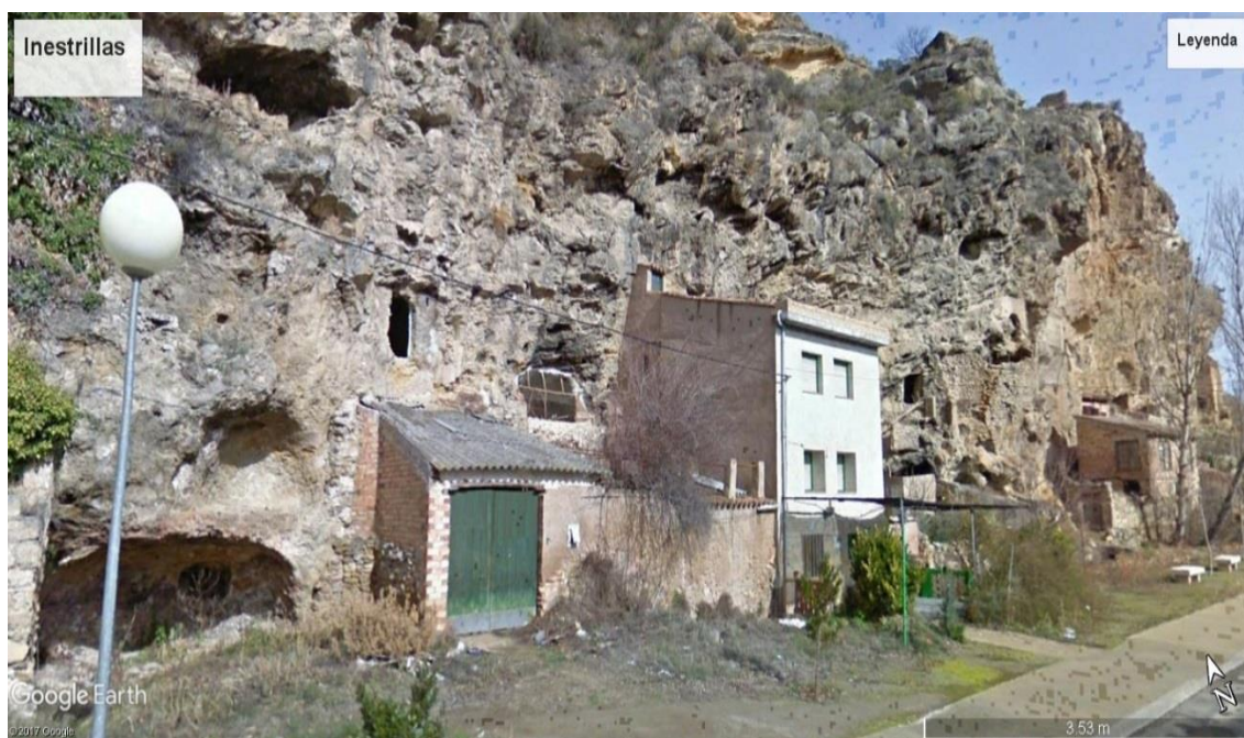
Viviendas-cueva excavadas en la roca en Inestrillas. Imagen: Google Earth Pro
