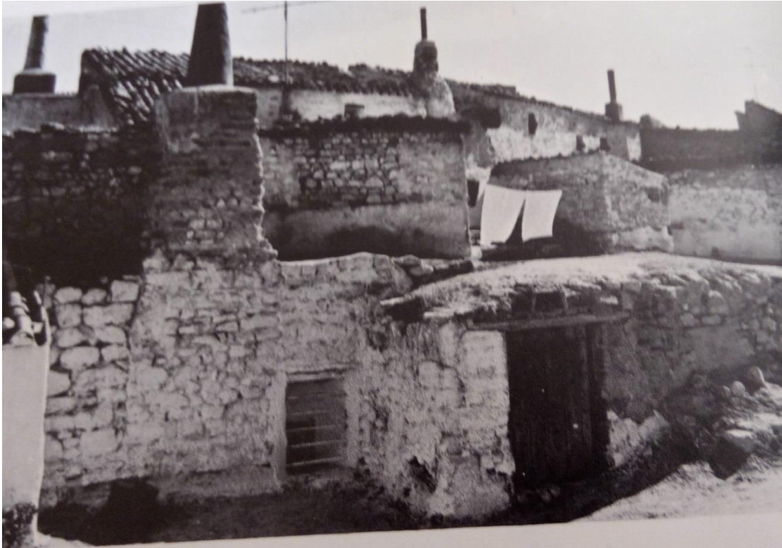
Conjunto de construcciones donde se mezclan la cueva, la construcción adosada y la exenta. La mampostería va intercalada, la cubierta es de teja y las chimeneas son esbeltas y de curiosas siluetas. Fuente: Luis Feduchi.
