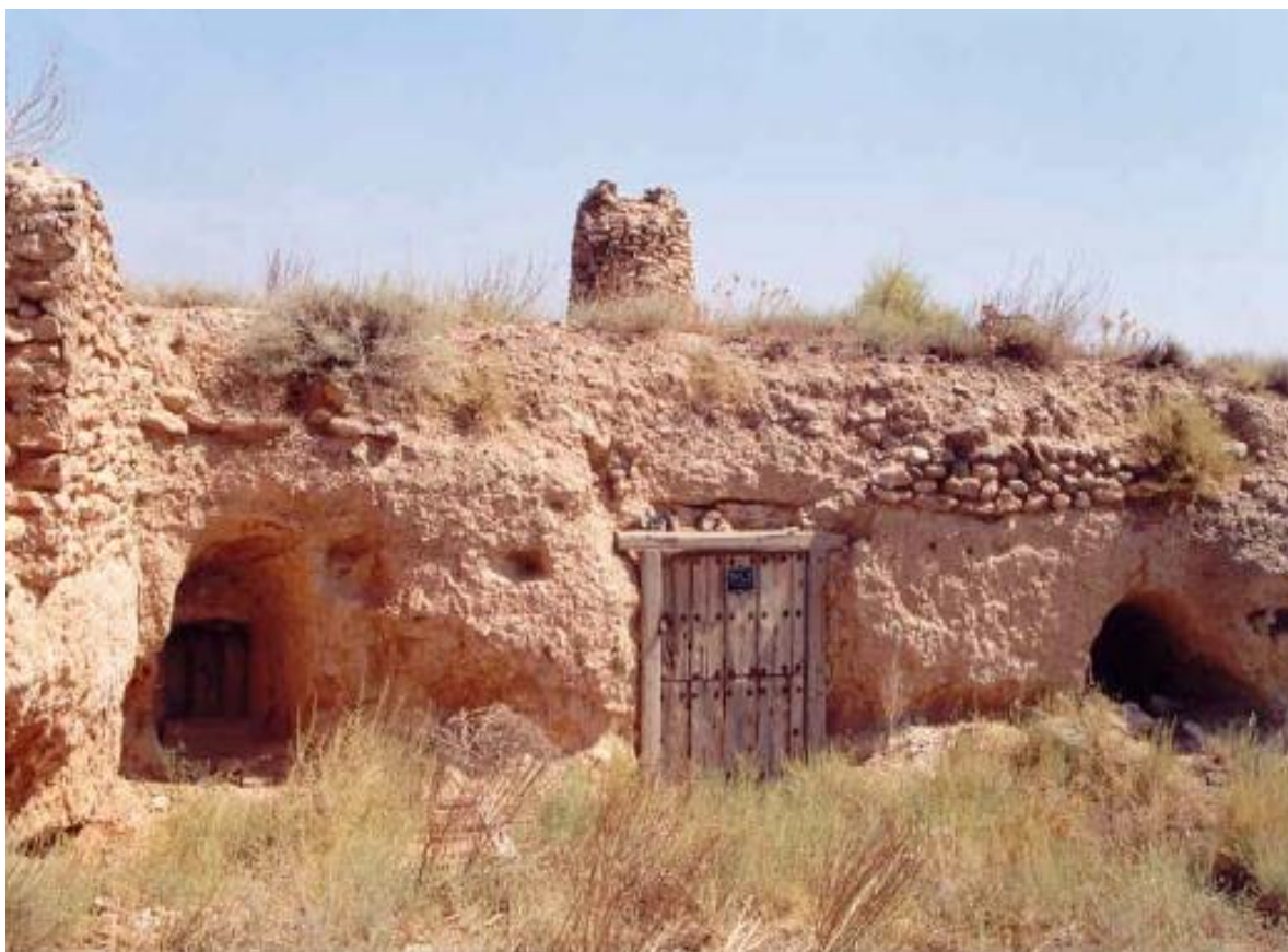
Fachada de cueva abierta en un cortado del terreno. Imagen: S. Aurenanz Campo, Las casas cueva de Salillas de Jalón, 2008, p. 26
