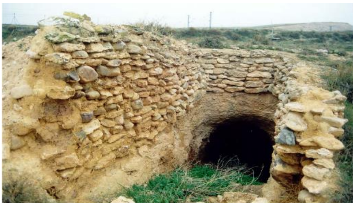
Vivienda cueva de Salillas de Jalón excavada en llano. Imagen: S. Aurenanz Campo, Las casas cueva de Salillas de Jalón, 2008, p. 31
