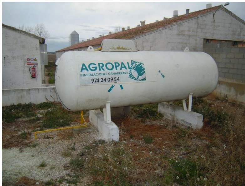
Ilustración 3 Depósito de GLP con capacidad para 4000 L.
