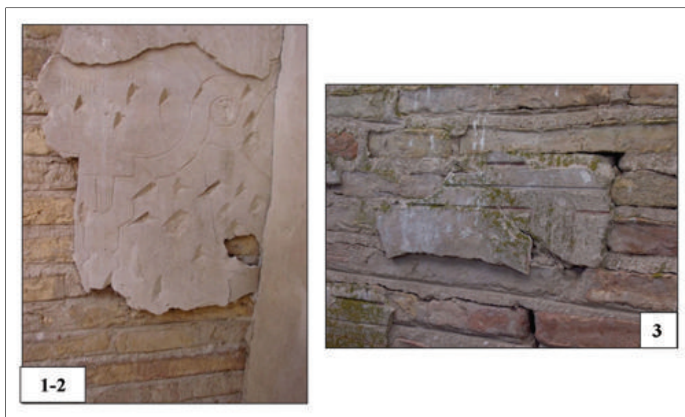
Figura 98. Zona de muestreo correspondiente a los pies del templo (Hastial). 1 y 2) Secuencia de dos enlucidos de yeso muestreados en el muro sur. Se observa una capa de enlucido original ( MGL-10 ) con repicado y restos de un dibujo inciso y una capa más externa (parte de arriba) correspondiente a un enlucido liso. 3) Enlucido de yeso con despiece de sillar similar al original perteneciente a una reforma posterior ( MGL-11 ).
