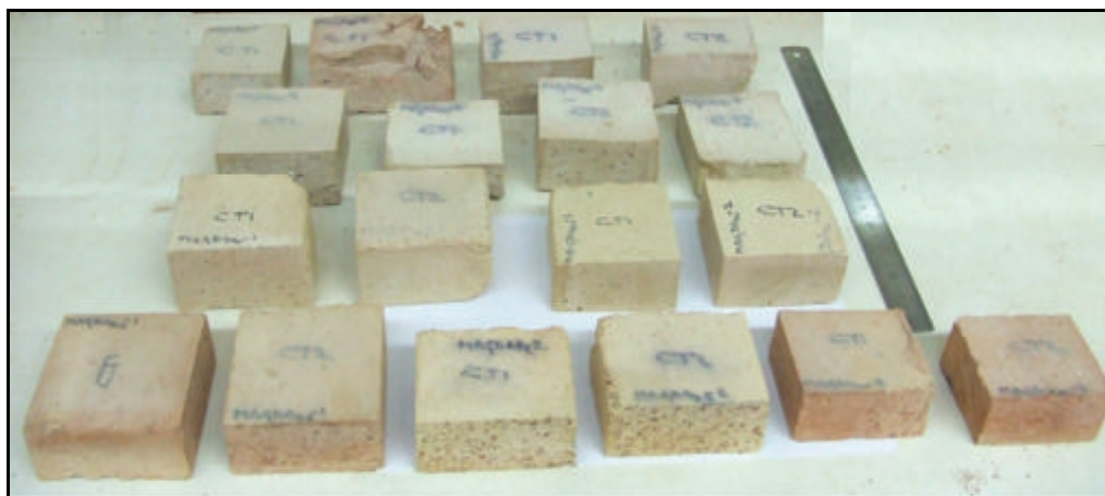
Figura 64. Aspecto que presentaban las probetas de los ladrillos de restauración tras el ensayo mediante ciclos de choque térmico. No se observaron daños significativos en las muestras.
