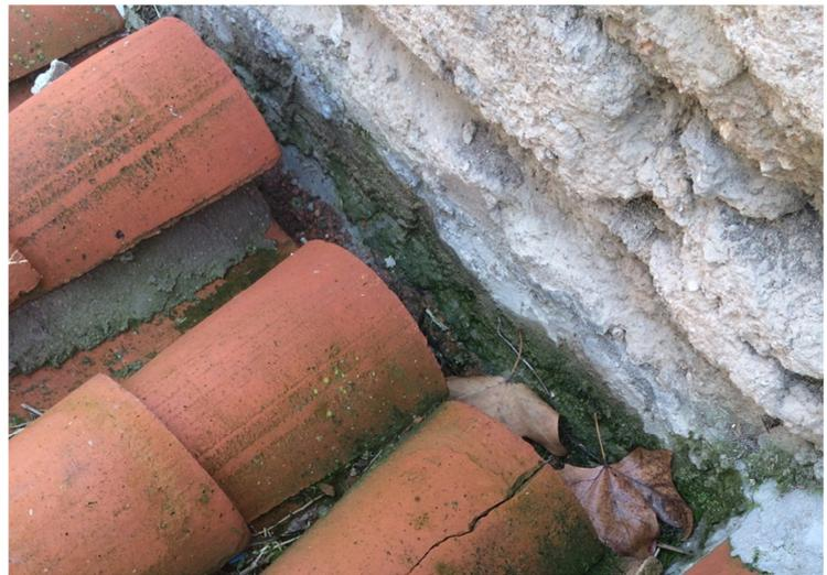
**Fig. 72. Humedad y moho en el canalón inferior.**
