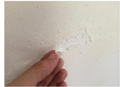
**Fig. 59. Desprendimiento de pintura.**
