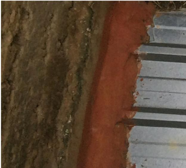
**Fig. 34. Separación muro-chapa.**
