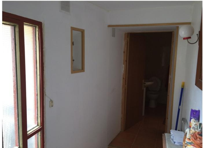
**Fig. 51. Recibidor. Trasdoso autoportante de placa de yeso laminado.**
