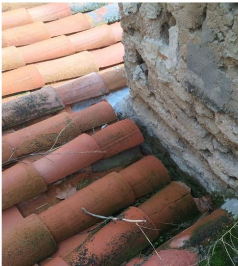
**Fig. 71. Canalón inferior afectado.**
