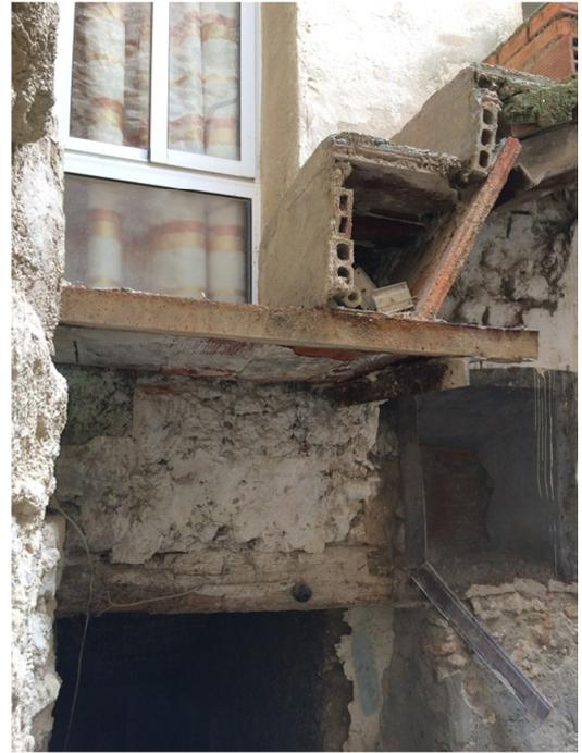
**Fig. 21. Acceso a la bodega (sótano) desde el patio exterior de la vivienda. Madero afectado y cargas que soporta.**
