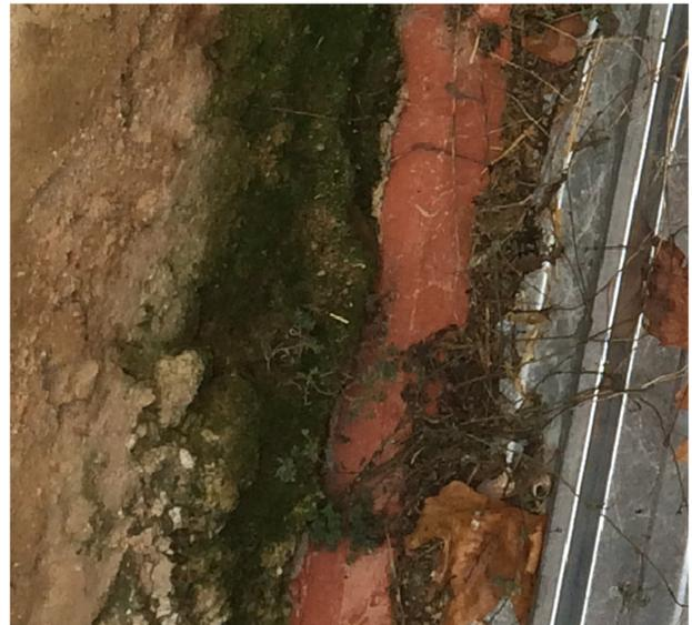
**Fig. 35. Separación muro-chapa. Existencia de moho.**
