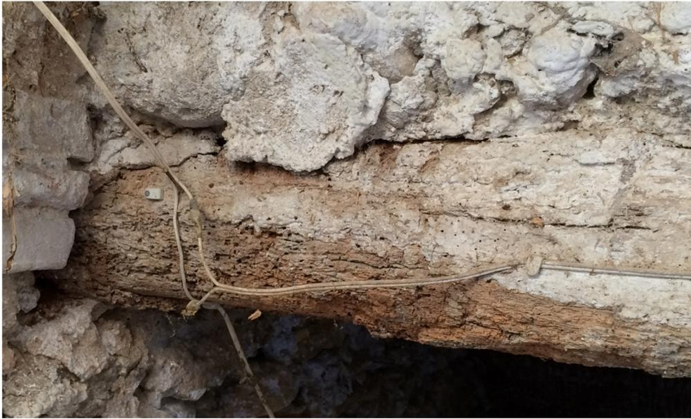
**Fig. 23. Extremo izquierdo del elemento estructural afectado. Cabeza podrida.**
