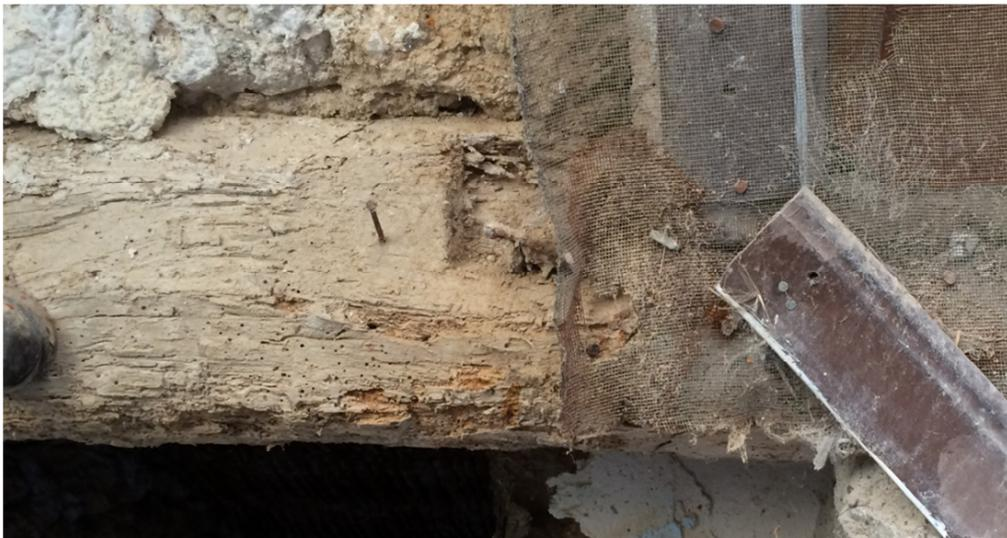
**Fig. 24. Extremo derecho del elemento estructural afectado. Cabeza podrida.**
