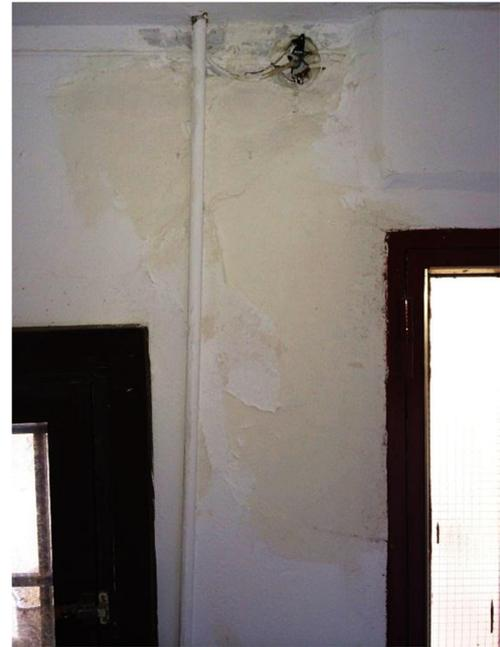
**Fig. 47.** Mancha de humedad entre la ventana y la puerta.
