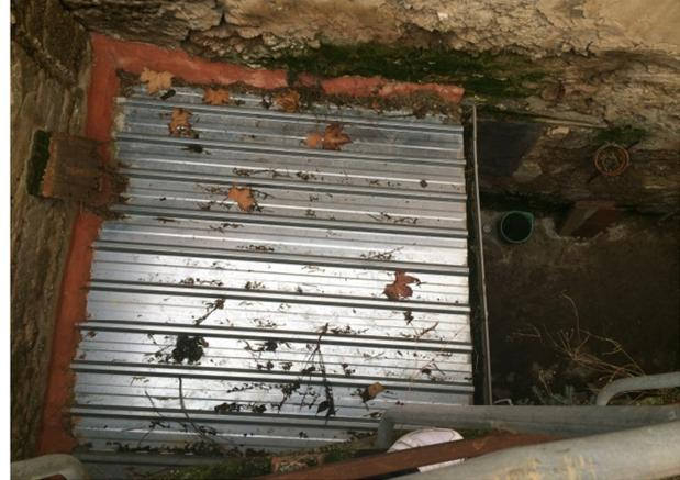
**Fig. 33. Vista en planta de la existencia de moho en uno de los laterales de la chapa.**
