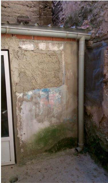
**Fig. 41. Moho en los encuentros muros-pavimento.**
