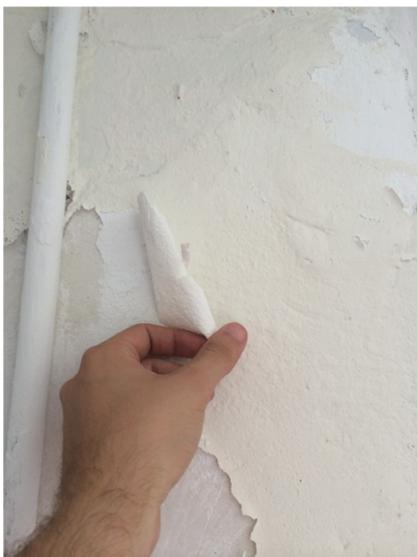
**Fig. 48.** Desprendimiento de pintura como consecuencia de la mancha de humedad.
