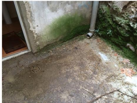
**Fig. 42. Moho en los encuentros muros-pavimento.**
