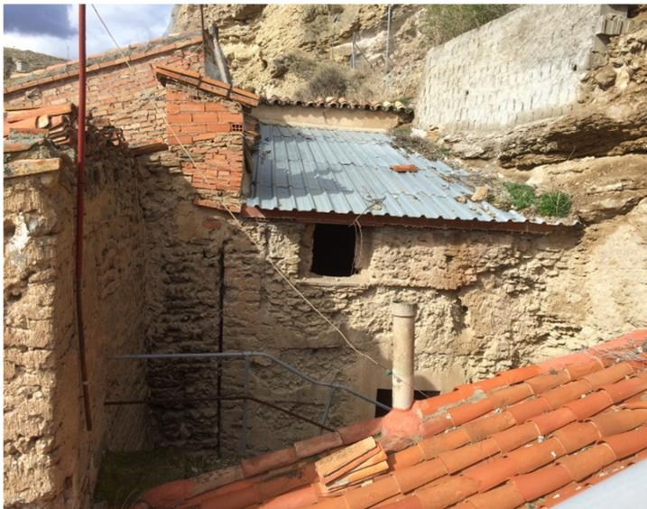
**Fig. 36. Vertido de aguas del local anexo sobre el patio exterior y la chapa que protege el baño de la vivienda objeto.**
