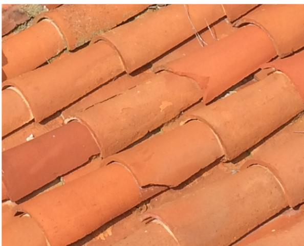
**Fig. 75. Tejas cobijas rotas por sus esquinas.**
