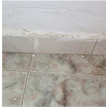
**Fig. 58. Desprendimiento de pintura.**
