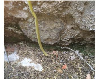
**Fig. 43. Moho en el encuentro muro-pavimento.**
