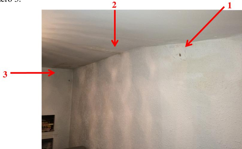
**Fig. 64.** Indicación y numeración de las tres manchas de humedad.
