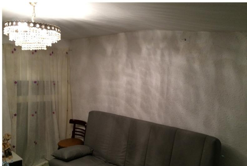
**Fig. 63. Paramento derecho y encuentro de este con el falso techo afectados por la humedad.**
