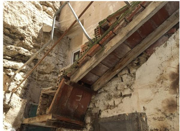
**Fig. 29. Desprendimiento del revoco en la pared del patio exterior.**
