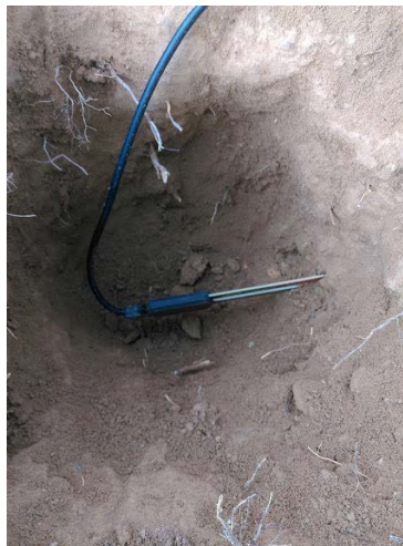
Figura 5. Instalación de una sonda 10 HS del equipo nº 5 (Elaboración propia)
