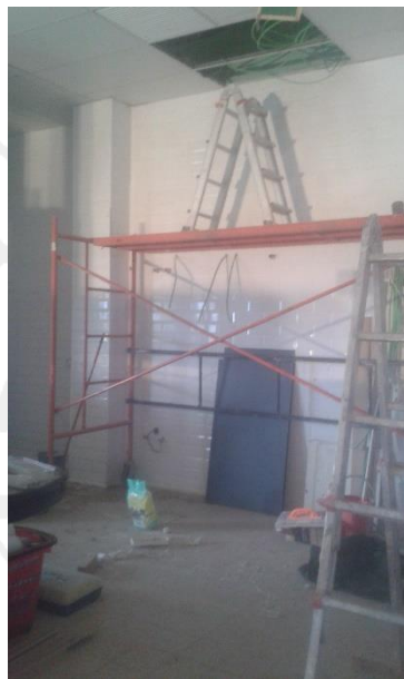
Imagen 6: utilización de escalera de mano sobre andamio.
