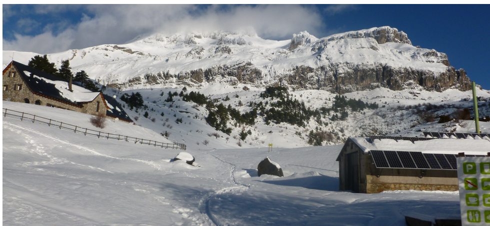
Figura 11: Localización de la caseta de los generadores con respecto al edificio principal.
