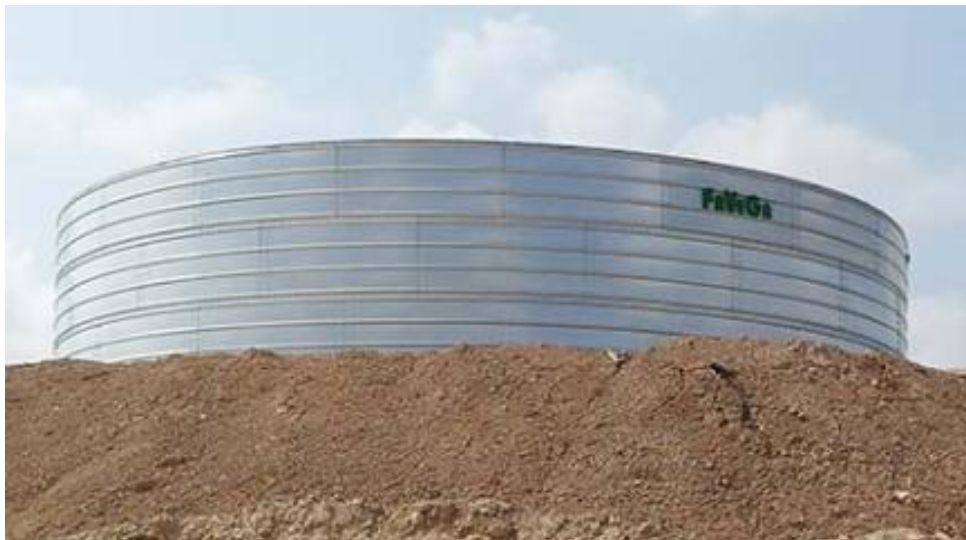
Ilustración 39 Depósito de agua
