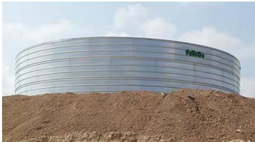
Ilustración 80 Depósito de agua
