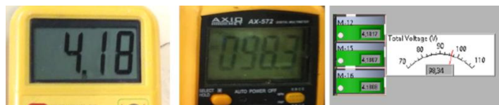
Ilustración 159: Toma de tensiones con multímetro.
