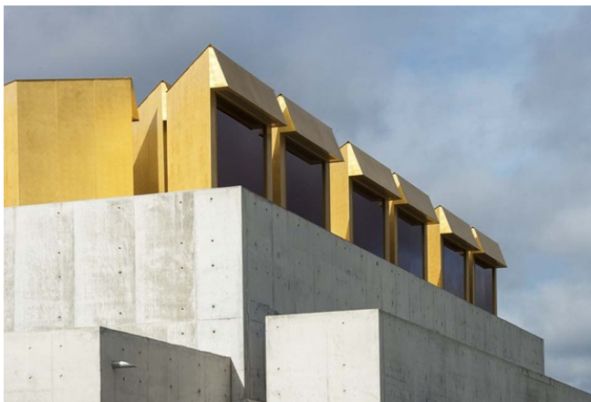
7. 14 vista exterior tragaluces
