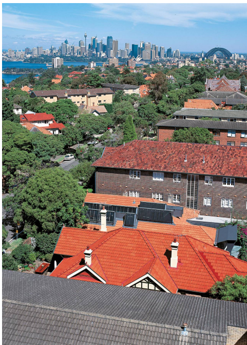
7.8 Vista de la cubierta
