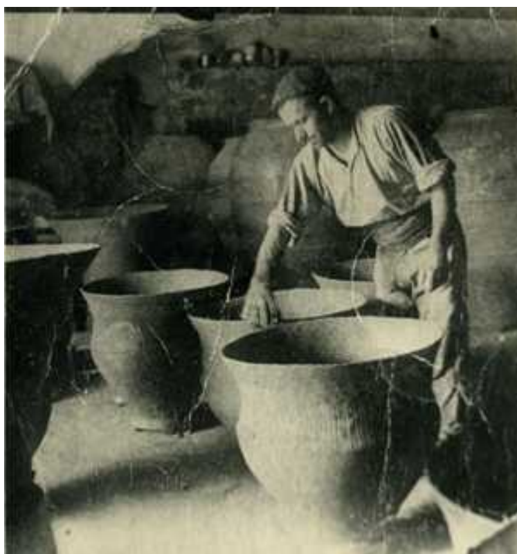
Fig. 24. “Marrelando” unos cocios en el obrador de los Manero.
