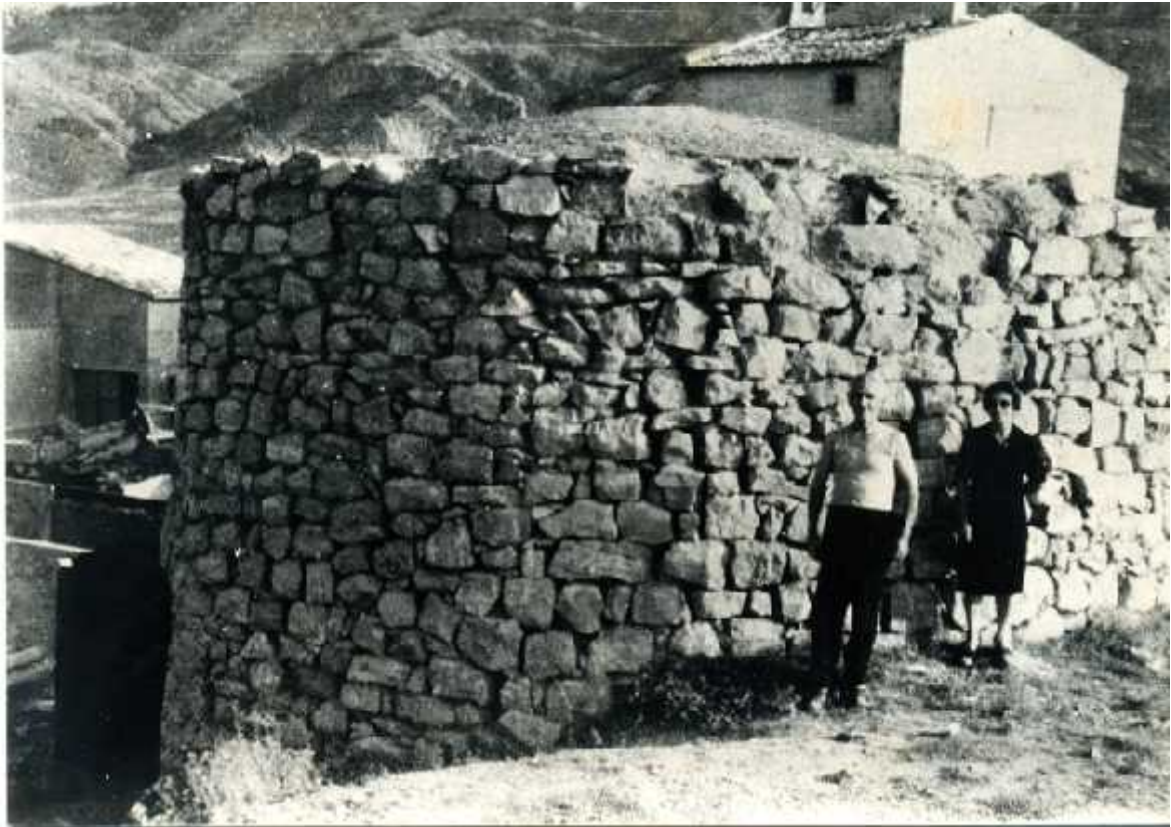
Fig. 11. Horno calandino con un alfarero y su mujer por la parte alta. En la parte inferior izquierda, se aprecia en un nivel más bajo la puerta de entrada a la “olla”. Vemos sus grandes dimensiones.
