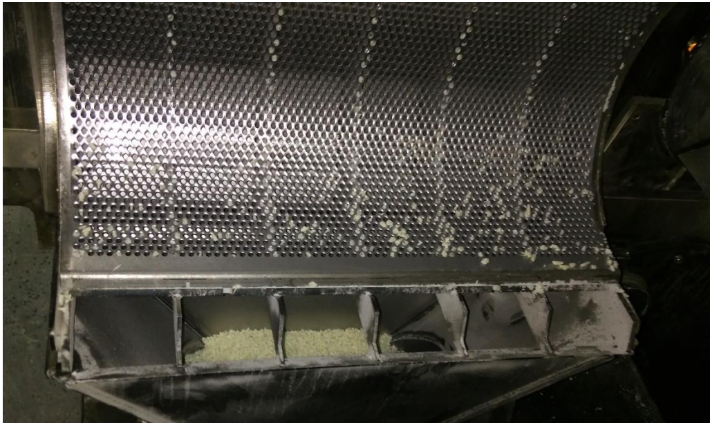
Ilustración 16 Compuerta del molino abierta.
