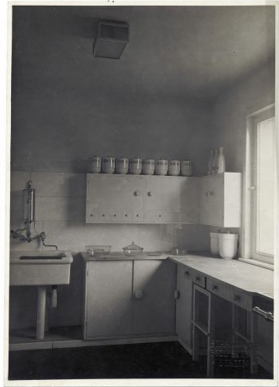
Cocina Haus Am Horn perteneciente a la Haus Am Horn [4]
