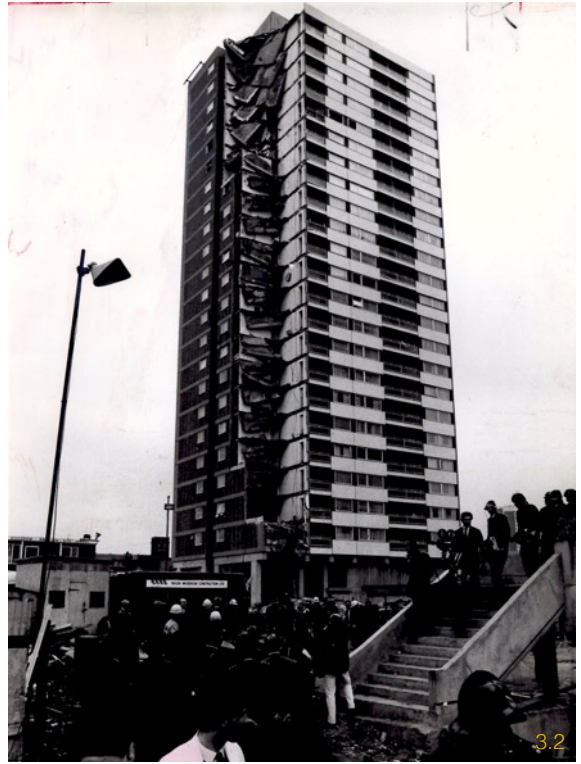
Derrumbamiento de el Ronan Point en 1968
