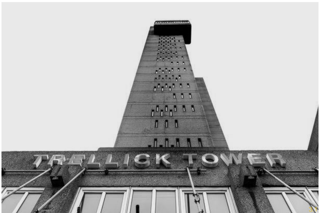
Núcleo de comunicaciones verticales de la Trellick Tower
