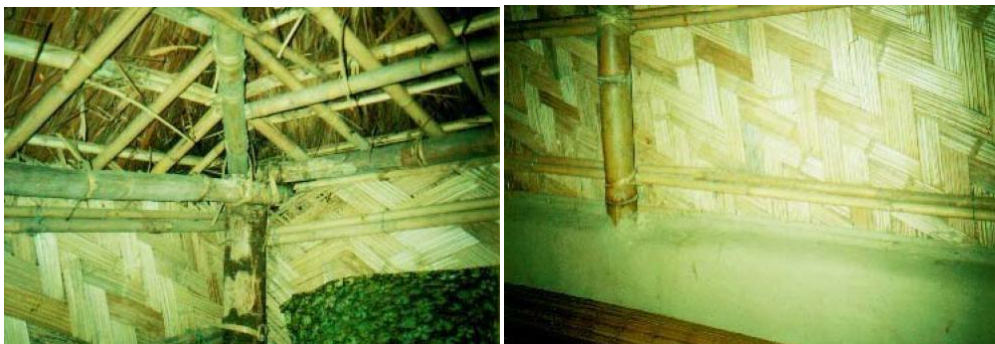
Figuras 4.1 y 4.2: Diferentes formas de unión entre cañas de bambú. [8]
